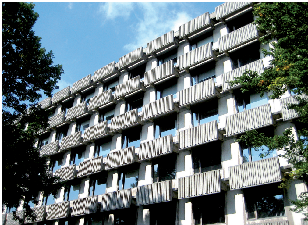
ill. 3 - Institut de Physique (Licences et Recherches), allée du Six août, allée de la Physique, 1967. Architecte P. Houbert. Photographie Homme et Ville, 2007.
