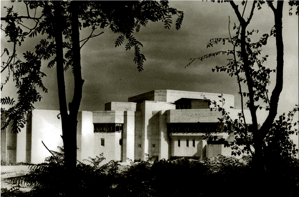
ill. 1 - Restaurant au Sart-Tilman, boulevard du Rectorat, 9, 1967. Architecte A. Jacqmain.
