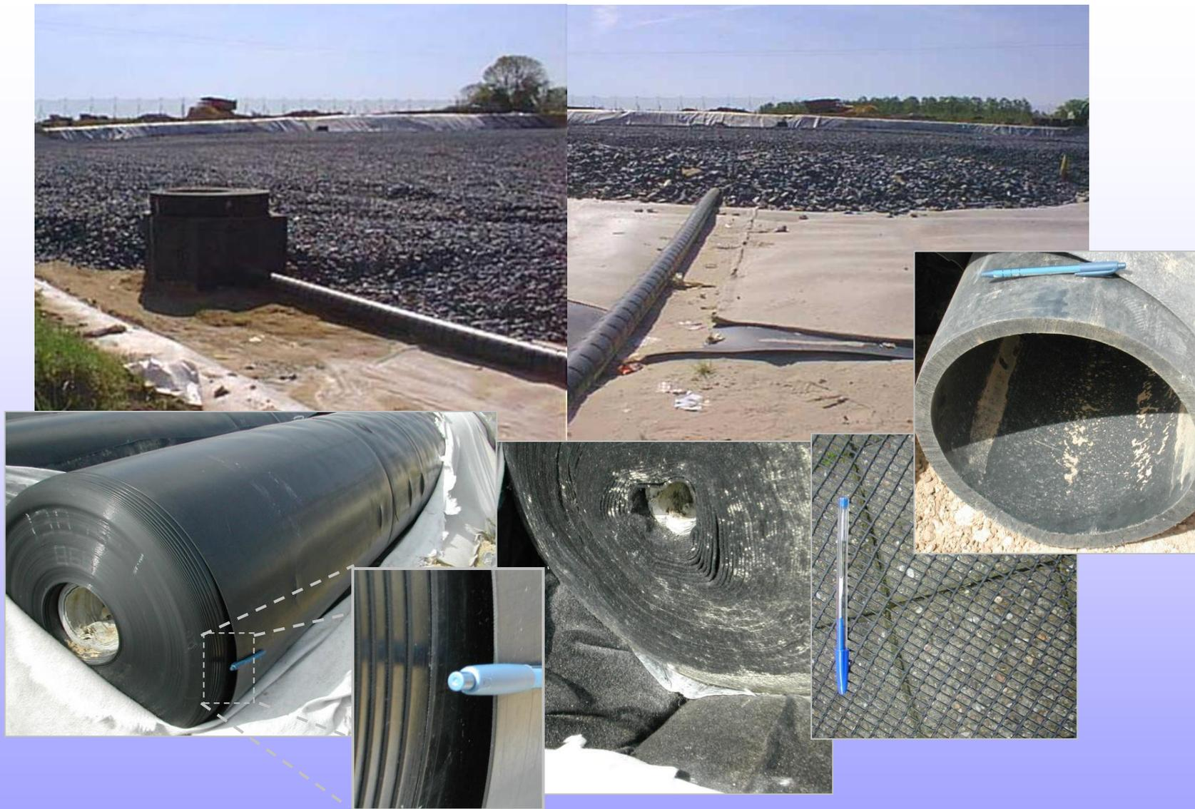
*Matériaux et vue d'ensemble du système de drainage des lixiviats dans un CET*
