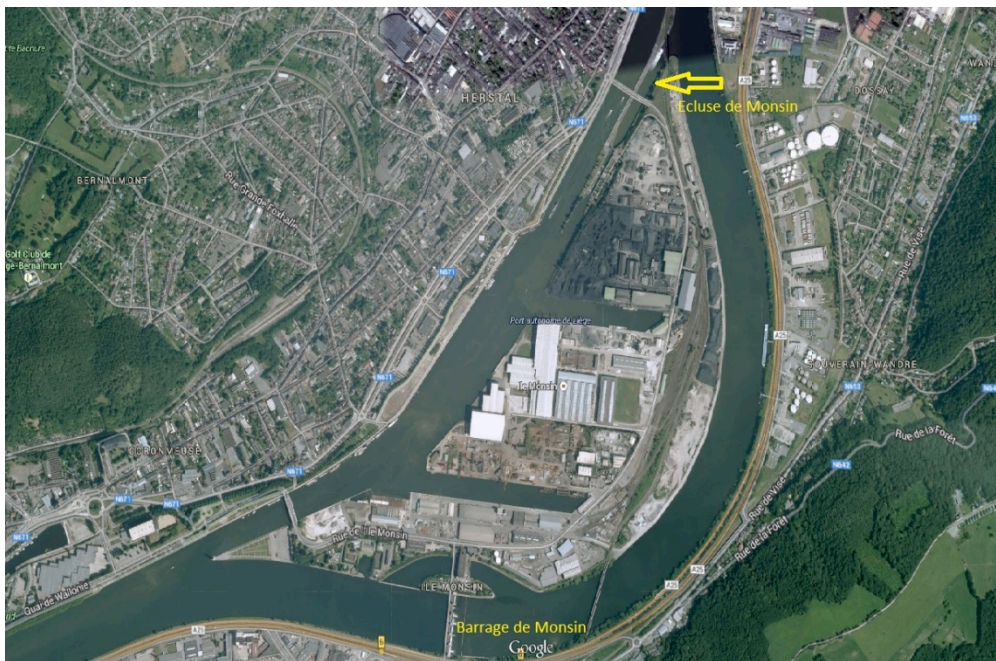
Figure 65. Vue aérienne du barrage de Monsin et de l'écluse de Monsin par où les poissons peuvent bifurquer vers le canal Albert et remonter vers la Meuse, sans passer par l'échelle à poissons du barrage de Monsin.
