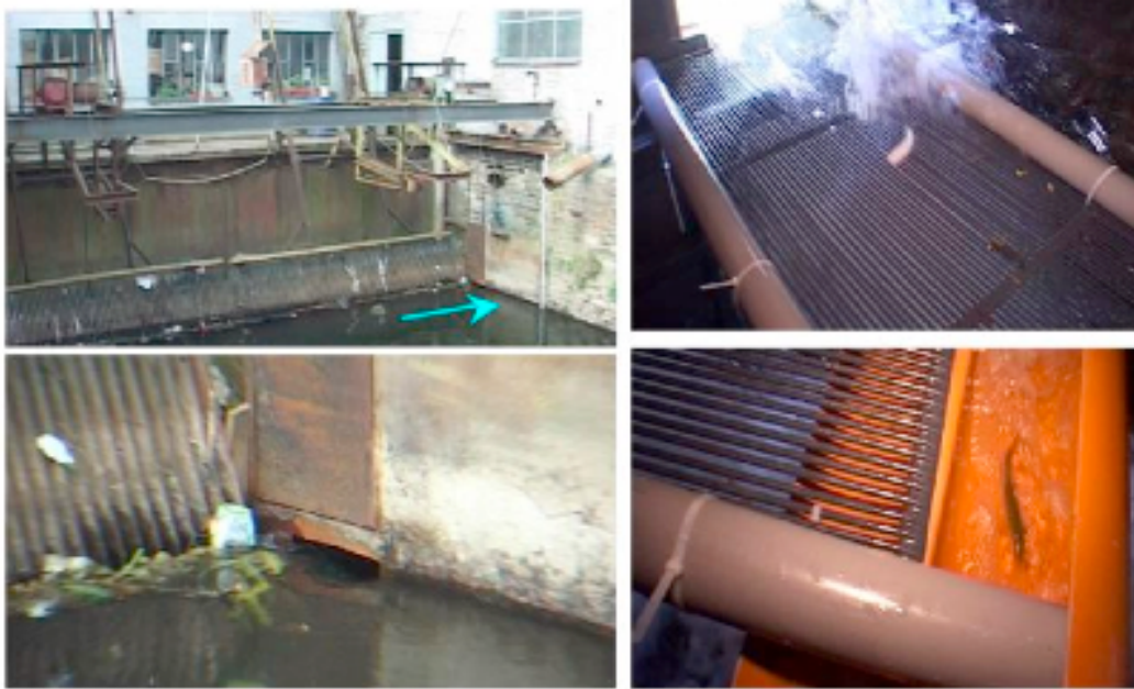
Figure 73. Vues (à gauche) de l'exutoire de dévalaison latéral (débit : 0,1-0,2 m 3 /s ; vitesse : 1-1,2 m 3 /s) aménagé dans le prolongement latéral de la grille de la prise d'eau de la centrale hydroélectrique Merytherm (10 m 3 /s maximum) sur l'Ourthe et (à droite) du système de récupération des poissons.
