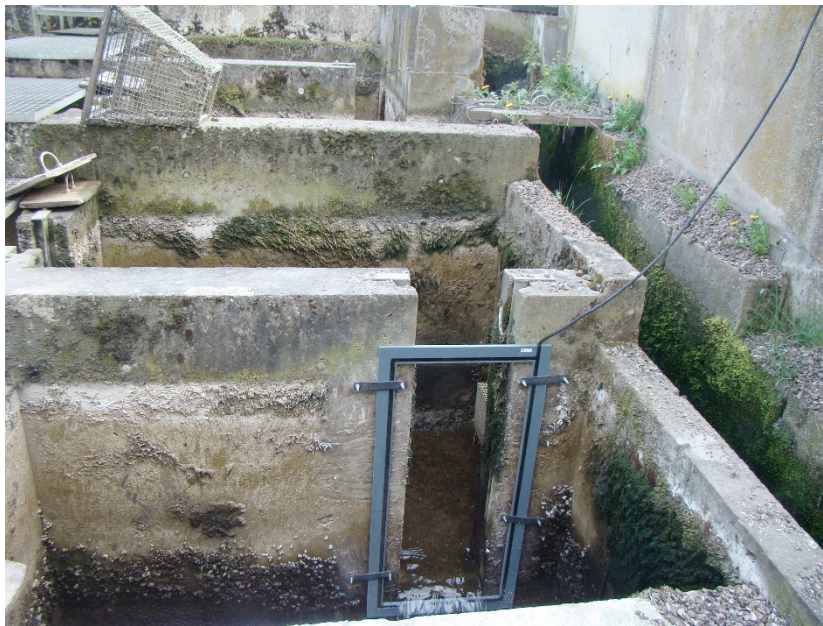
Figure 62. Au-dessus : antenne de détection RFID placée au niveau d'une échancrure à l'amont de la grande échelle à poissons de Lixhe sur la Meuse. En dessous : antenne de détection RFID placée au niveau d'une échancrure à l'amont de la petite échelle à poissons de Lixhe sur la Meuse.
