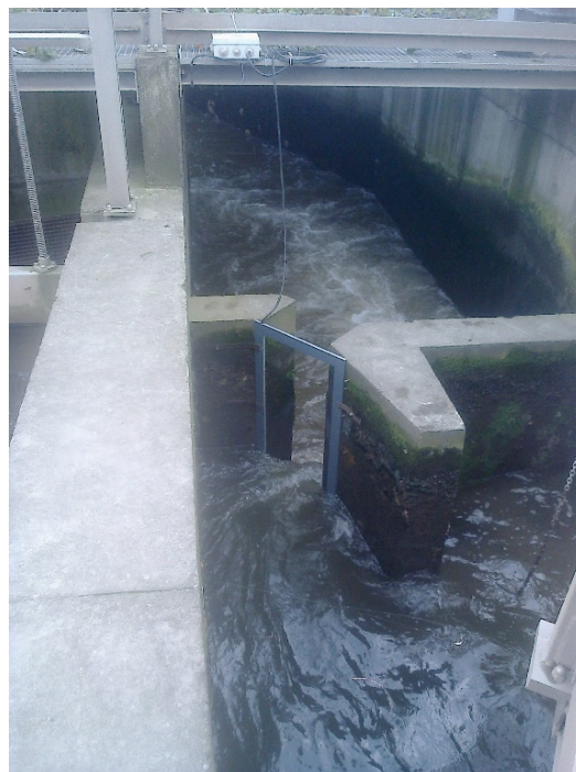
Figure 59. Partie supérieure de l'échelle à poissons à bassins du barrage de Monsin-Liège sur la Meuse (km 114,6). L'antenne de détection RFID a été placée au niveau de la dernière échancrure de la passe à poissons de Monsin.
