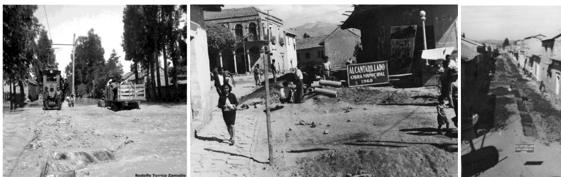
Fotografías n° 2: Instalación de redes alcantarillado en la década de 1960. Fuente: Archivos fotográficos Torrico Zamudio 2013, y Galindo Gómez, 2012
