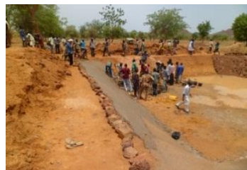
Imperméabilisation d'un bassin
