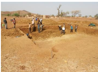
Excavation d'un bassin
