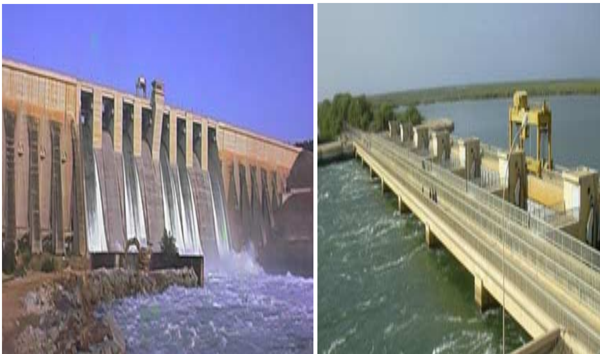
Figure I-16 : Barrage hydro-électrique de Manantali et barrage antisel de Diama
