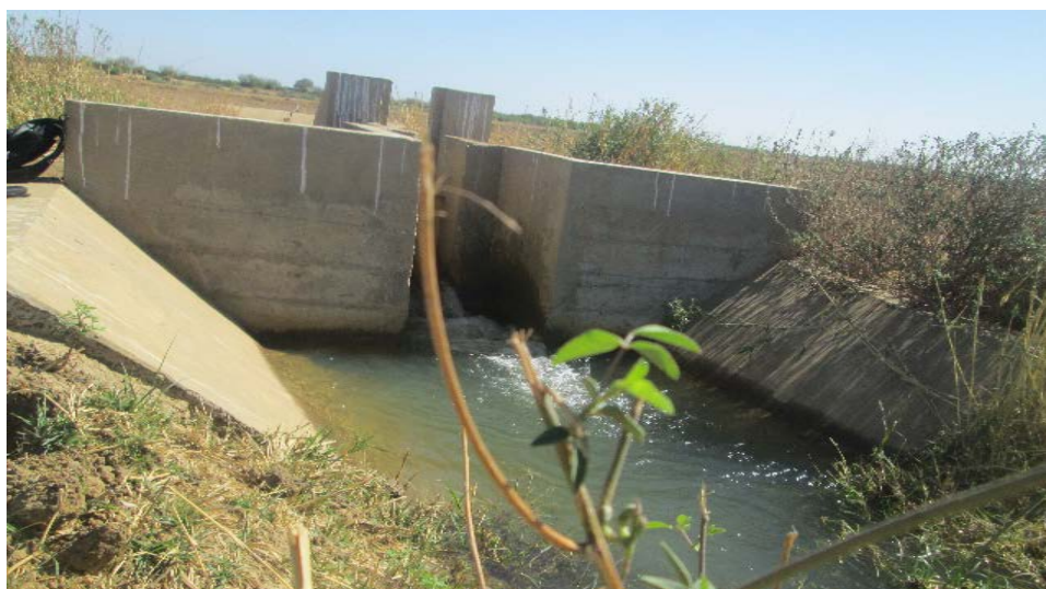
Figure IV-8 : Tête de canal secondaire
