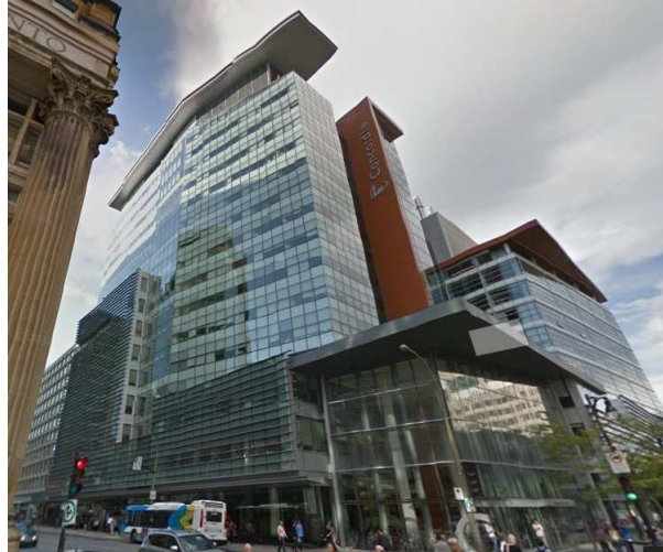
FIGURE 4.86: Illustration du bâtiment étudié
