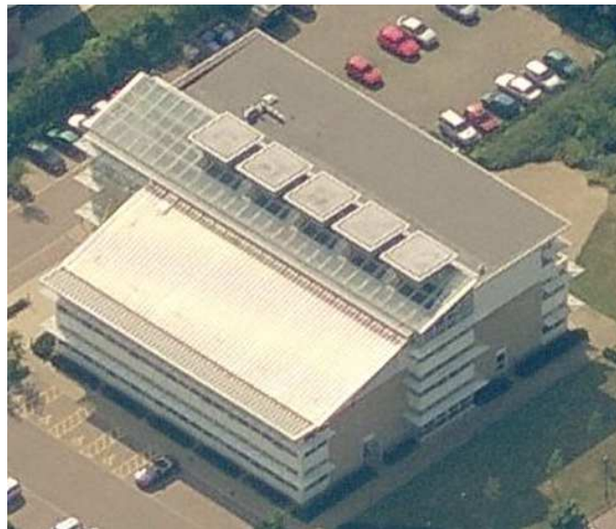
FIGURE 4.76: Illustration du bâtiment étudié
