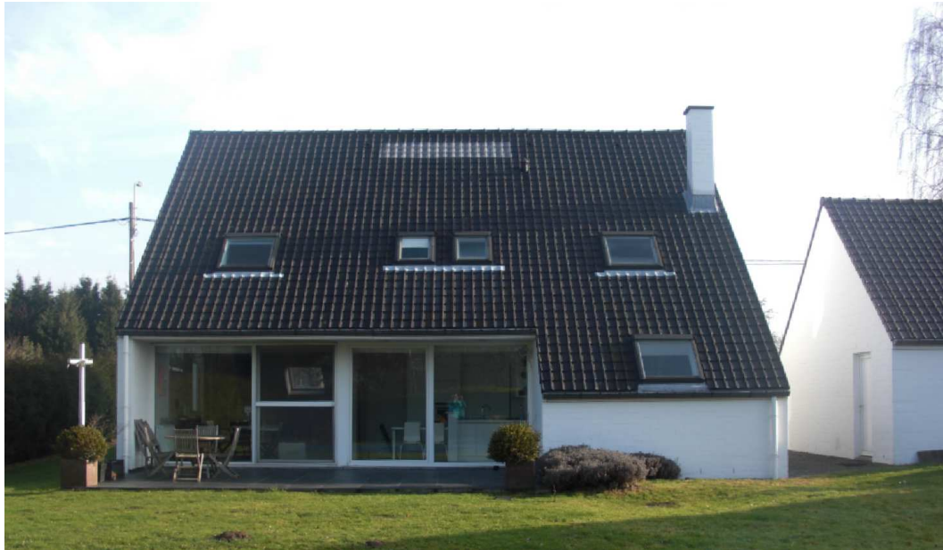
FIGURE 6.2: Vue de la façade arrière
