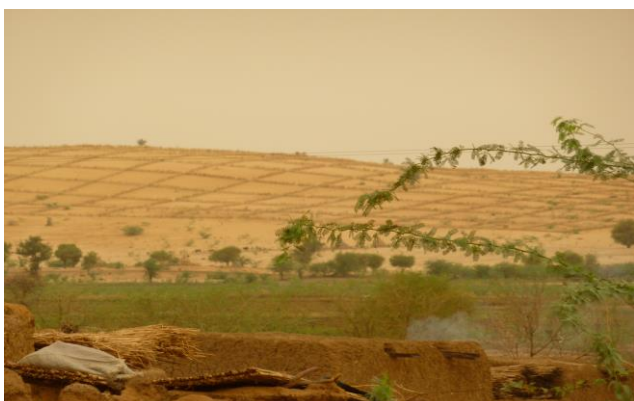
Fixation de dune à base des tiges du Mil M. MOUSSA DIT KALAMOU, 2010
