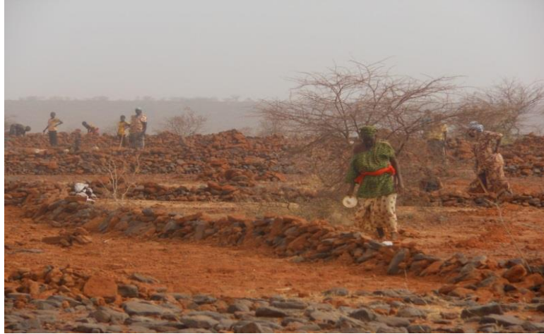
Photo 5 : Ouvrage de freinage du ruissellement des eaux de pluie sur plateau réalisé par les femmes Source : Enquête de terrain 2012
