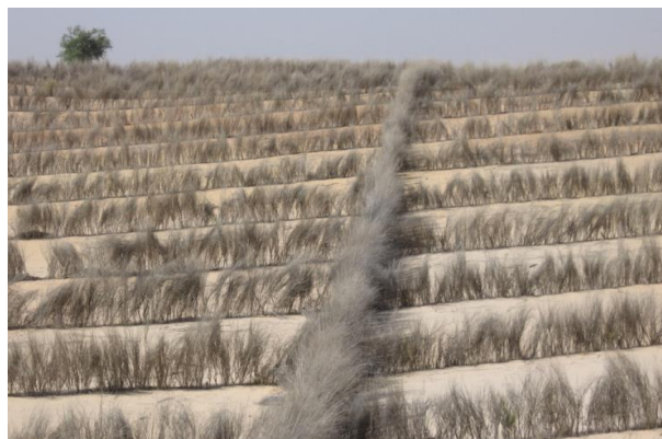
Fixation de dune à base des rachis du palmier doum A.K. MALAM BOUKAR, 2012
