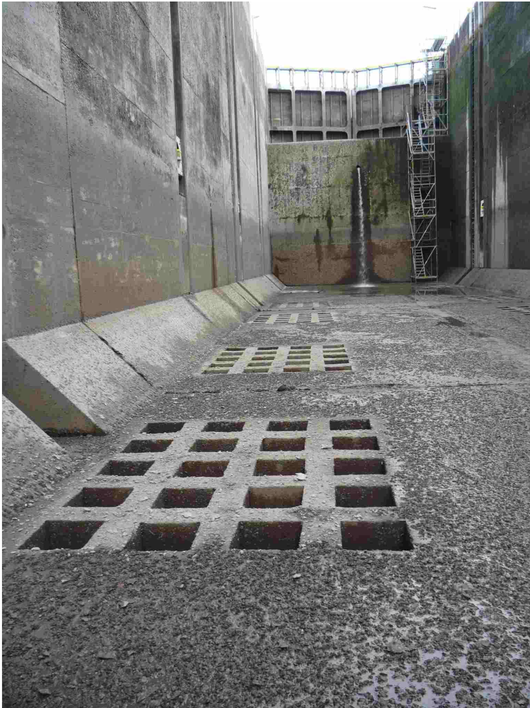
FIGURE 3.4 – Vue de l'intérieur du sas de l'écluse de Havré (2)
