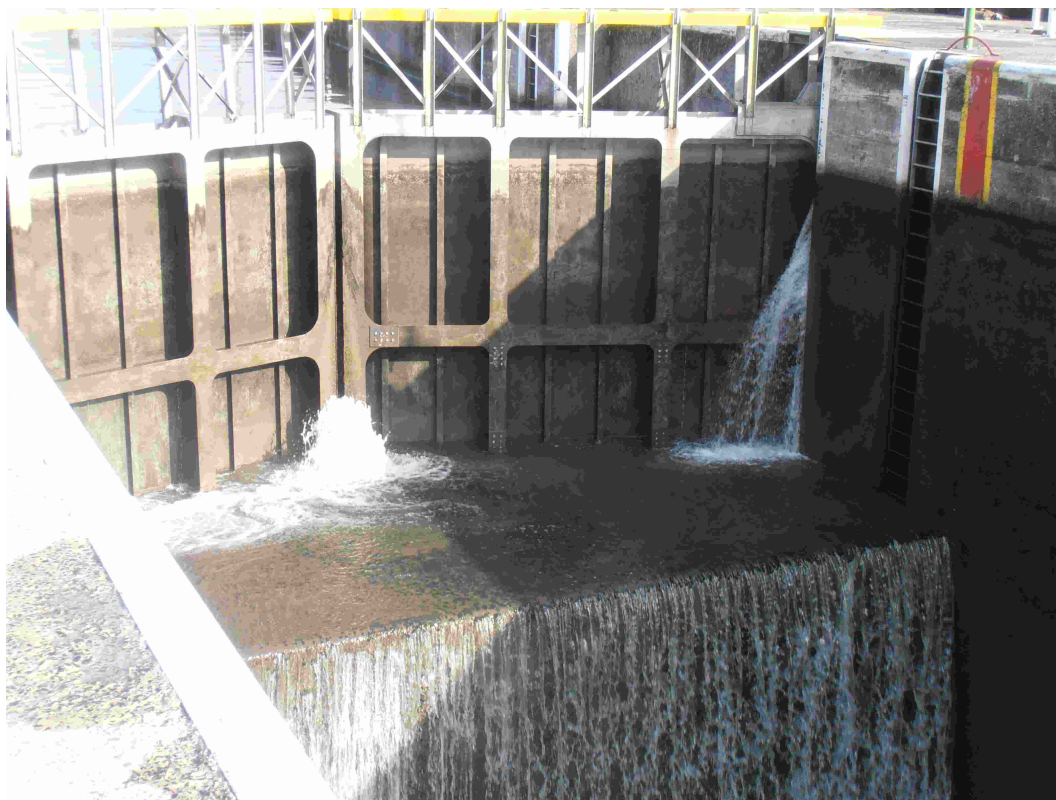
FIGURE 4.6 – Vue de la partie aval de la porte amont [Vercruysse]
