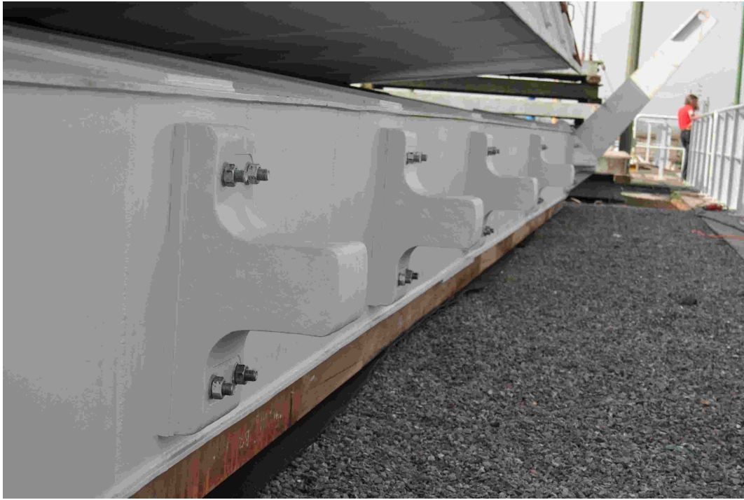
FIGURE 2.3 – Heurtoirs du poteau tourillon d’une porte aval de l’écluse de Havré
