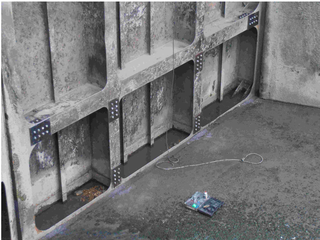
FIGURE 4.11 – Renforcement de la porte amont en 2011 [Verduytsse]
