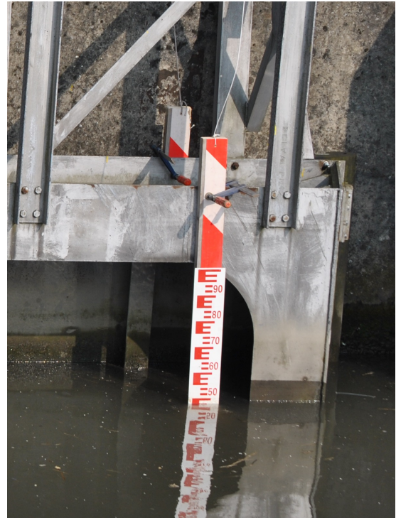
(b) Niveau du canal à la fin de l'ouverture
