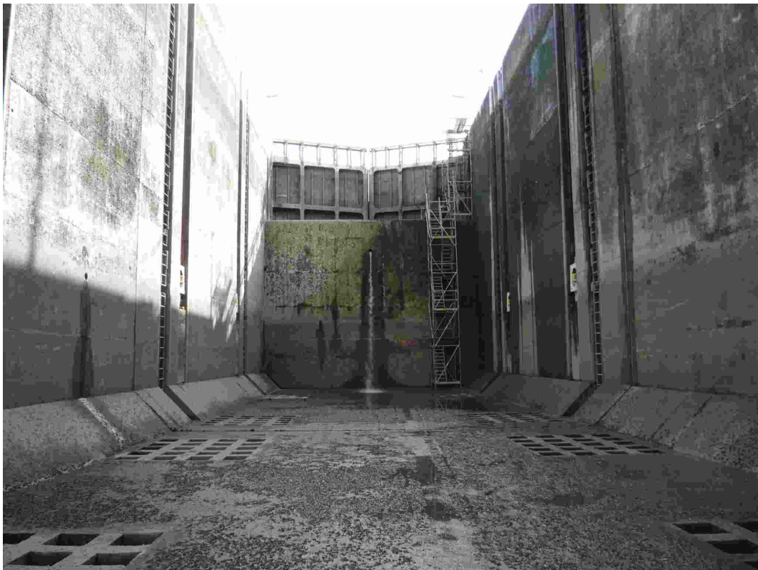
FIGURE 2.1 – Vue de l'intérieur du sas de l'écluse de Havré
