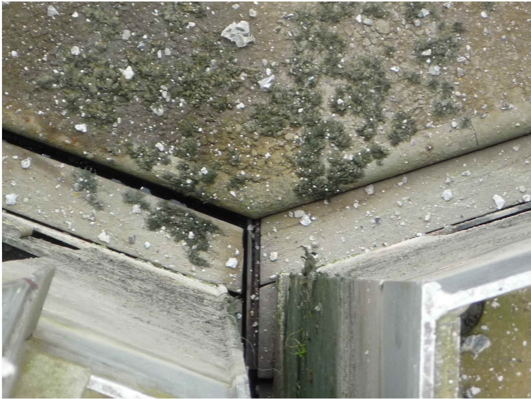
FIGURE 5.73 – Vue de la base du poteau busqué
