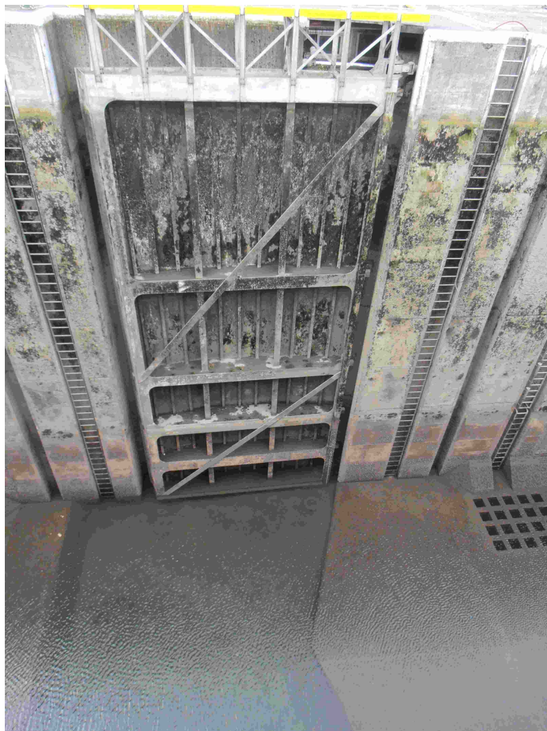
FIGURE 4.1 – Vue de la partie aval de la porte aval [Veracruz]
