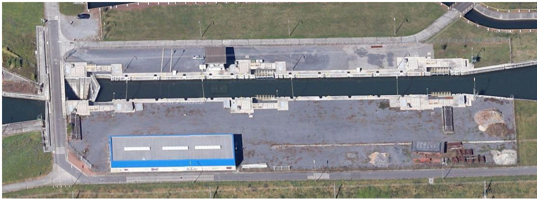
FIGURE 3.3 – Vue aérienne de l'écluse de Havré [Google, 2014]
