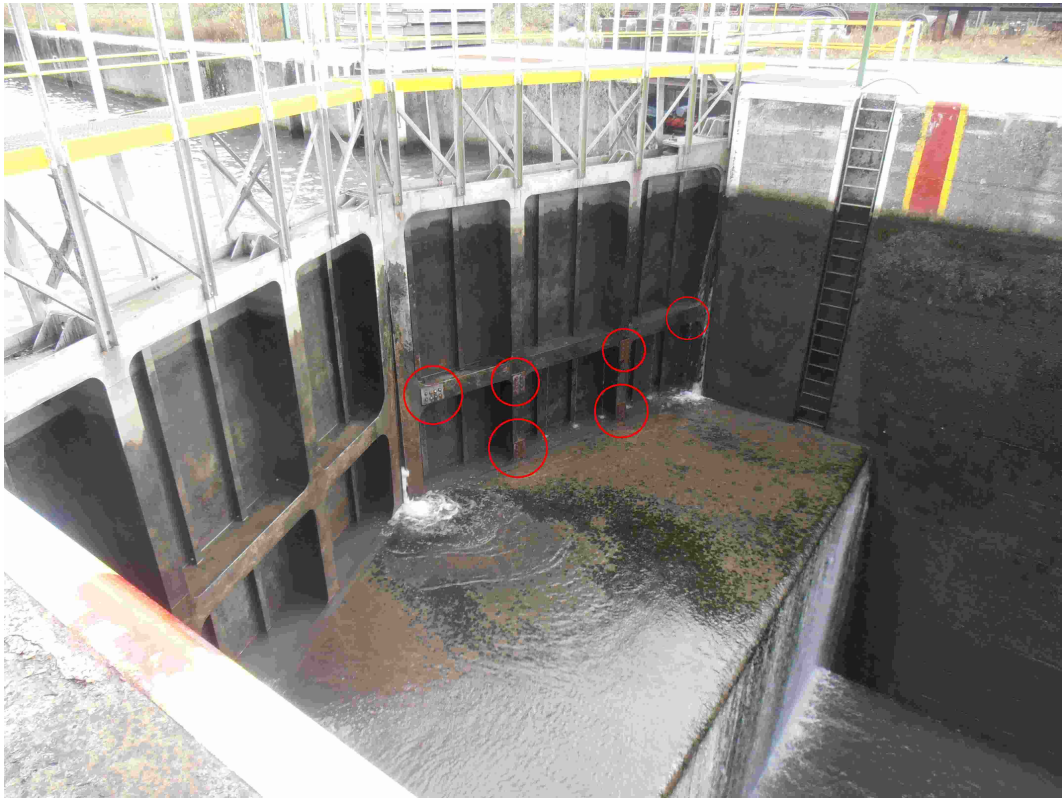
FIGURE 4.10 – Renforcement de la porte amont en 2011 (vue générale) [Verduytsse]
