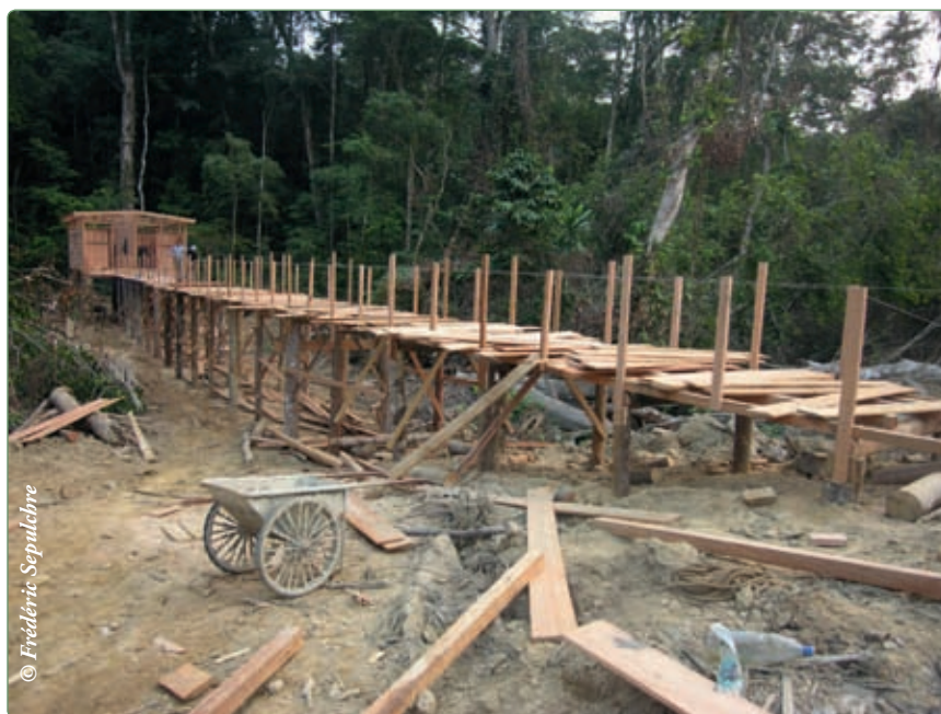
Photo 2.10: Aménagement de latrines pour un camp de travailleurs au Gabon
