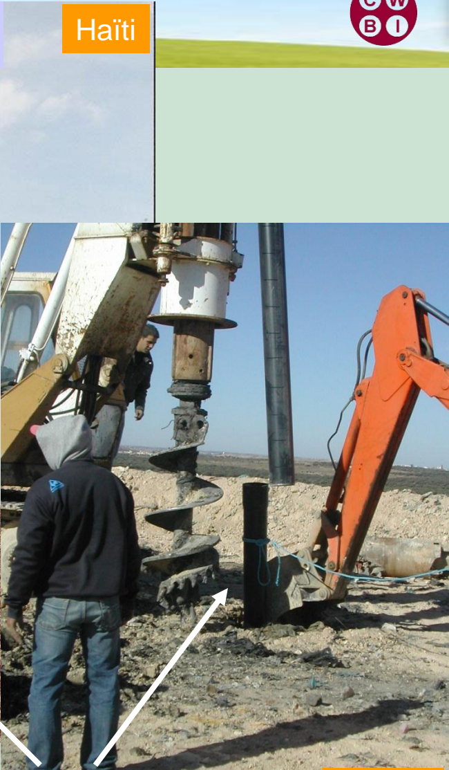
Pose de tubes de dégazage
