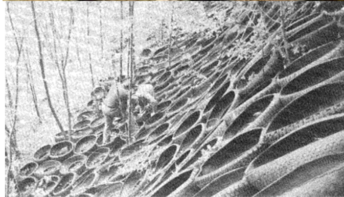
protection des pentes en Suisse
