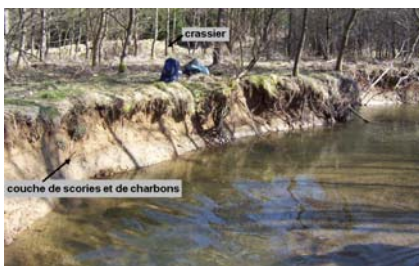
Berge érodée de la Chavanne à proximité d'un ancien site de haut fourneau
