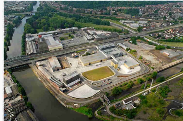
Bâtiment Umicore Angleur
