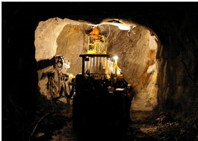
Fig. 8 Jumbo perforateur en action dans la mine de Lisheen en avril 2009.
