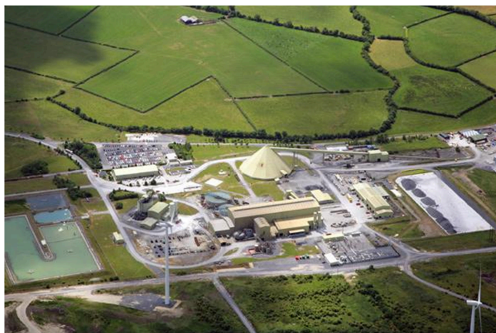
Fig. 9 Vue aérienne des infrastructures de surface de la mine de Lisheen. © Vedanta
