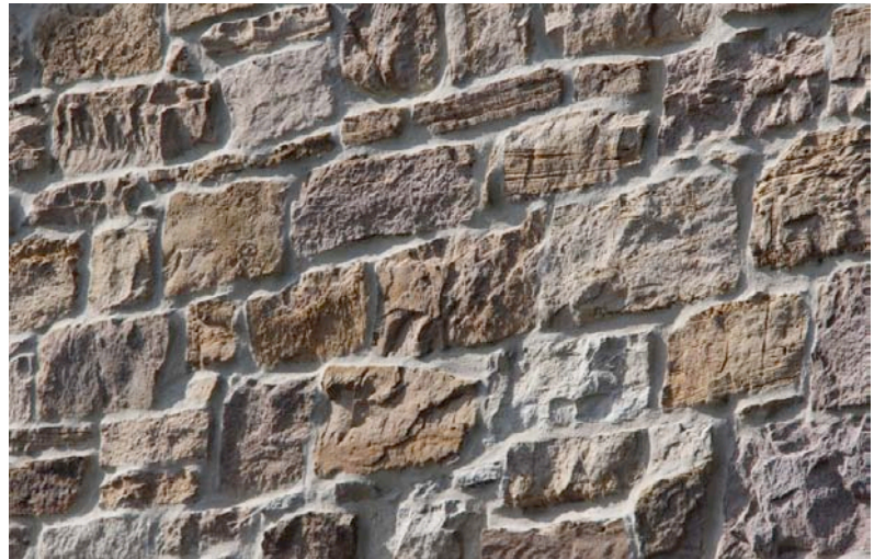
Rue du Grand Poirier – Construction en grès famennien
