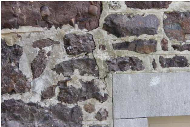
Poudingue de la Formation de Burnot dans le mur des maisons anciennes
