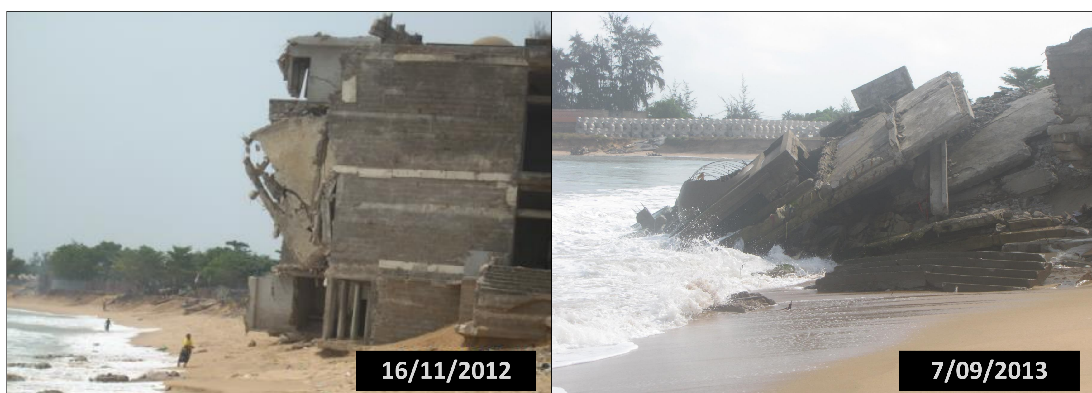
Figure 2: Illustration du recul de la plage et de la destruction de bâtiments à l'est de Cotonou. Ici, la même construction à 10 mois d'intervalle. Ce bâtiment (positionné par une étoile sur la Fig. 1) actuellement détruit se trouvait à 100 m de la plage en 2002 (Clichés: Y.C. Hountondji, 2012; P. Ozer, 2013).
