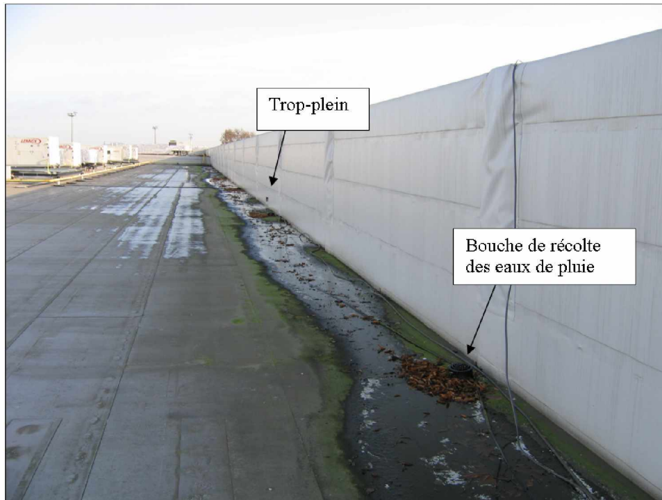
Figure 14 : Vue des évacuations et du mur de protection d'une toiture récoltant les eaux de pluie [Auteur : Degré A., 2006].
