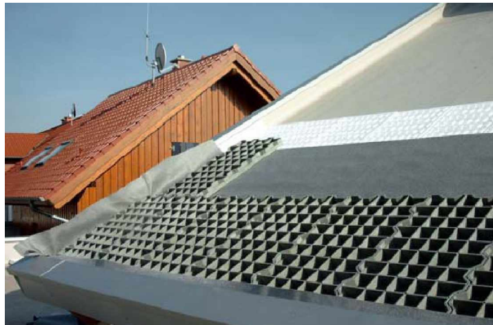
Figure 10 : Mise en place d'une toiture verte en pente, système de stockage d'eau
