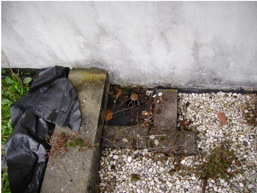
Figure 51 : Evacuation d'une zone de toiture [Auteur : Beckers E., 2006].
