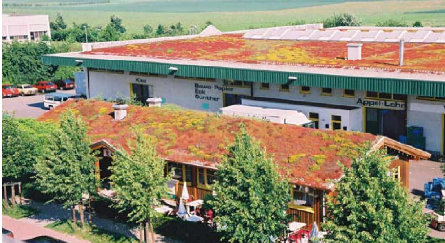
Figure 5 : Toiture extensive [Source : Btech nv. sa, 2006 consulté le 10/07/06].
