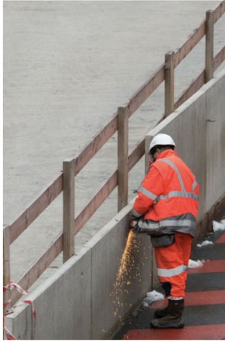
Figure 5 : Photo du chantier des Halles Crédits : SemPariSeine – Franck Badaire, Photographe
