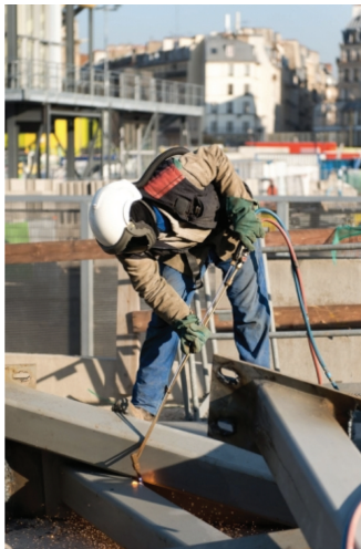
Figure 6 : Photo du chantier des Halles Crédits : SemPariSeine – Franck Badaire, Photographe
