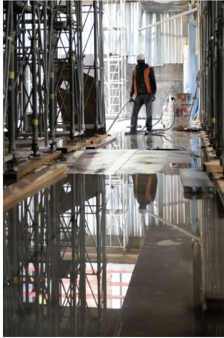
Figure 7 : Photo du chantier des Halles Crédits : SemPariSeine – Franck Badaire, Photographe
