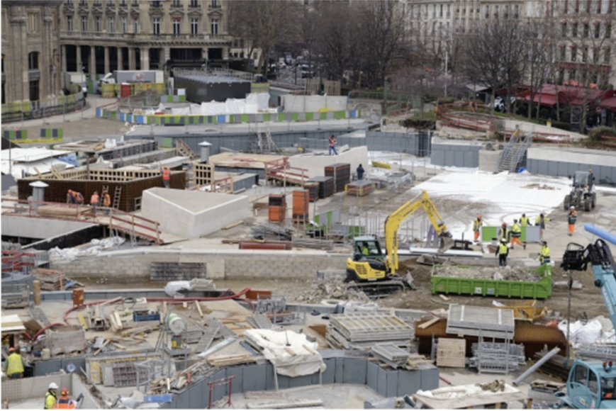
Figure 8 : Photo du chantier des Halles Crédits : SemPariSeine – Franck Badaire, Photographe
