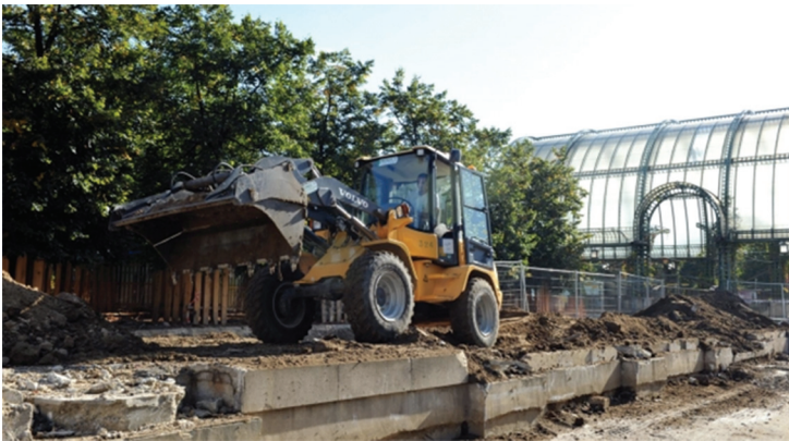
Figure 9 : Photo du chantier des Halles Crédits : SemPariSeine – Franck Badaire, Photographe
