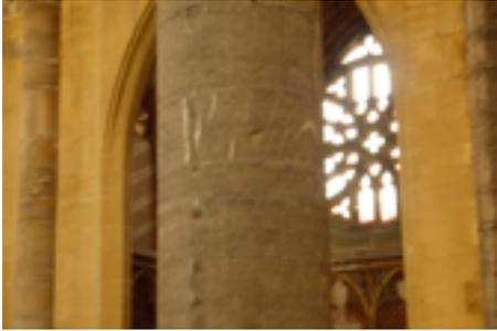
(en surface) → le matériau devient noir. Cela se voit particulièrement au niveau des joints (formation de croûtes → sulfate + suie = couleur noire à enlever de manière mécanique.
