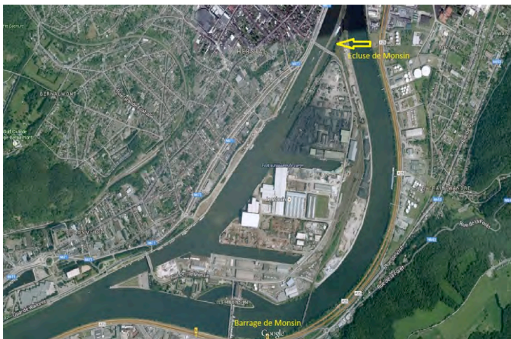
Figure 82. Vue aérienne du barrage de Monsin et de l'écluse de Monsin par où les poissons peuvent bifurquer vers le canal Albert et remonter vers la Meuse, sans passer par l'échelle à poissons du barrage de Monsin.
