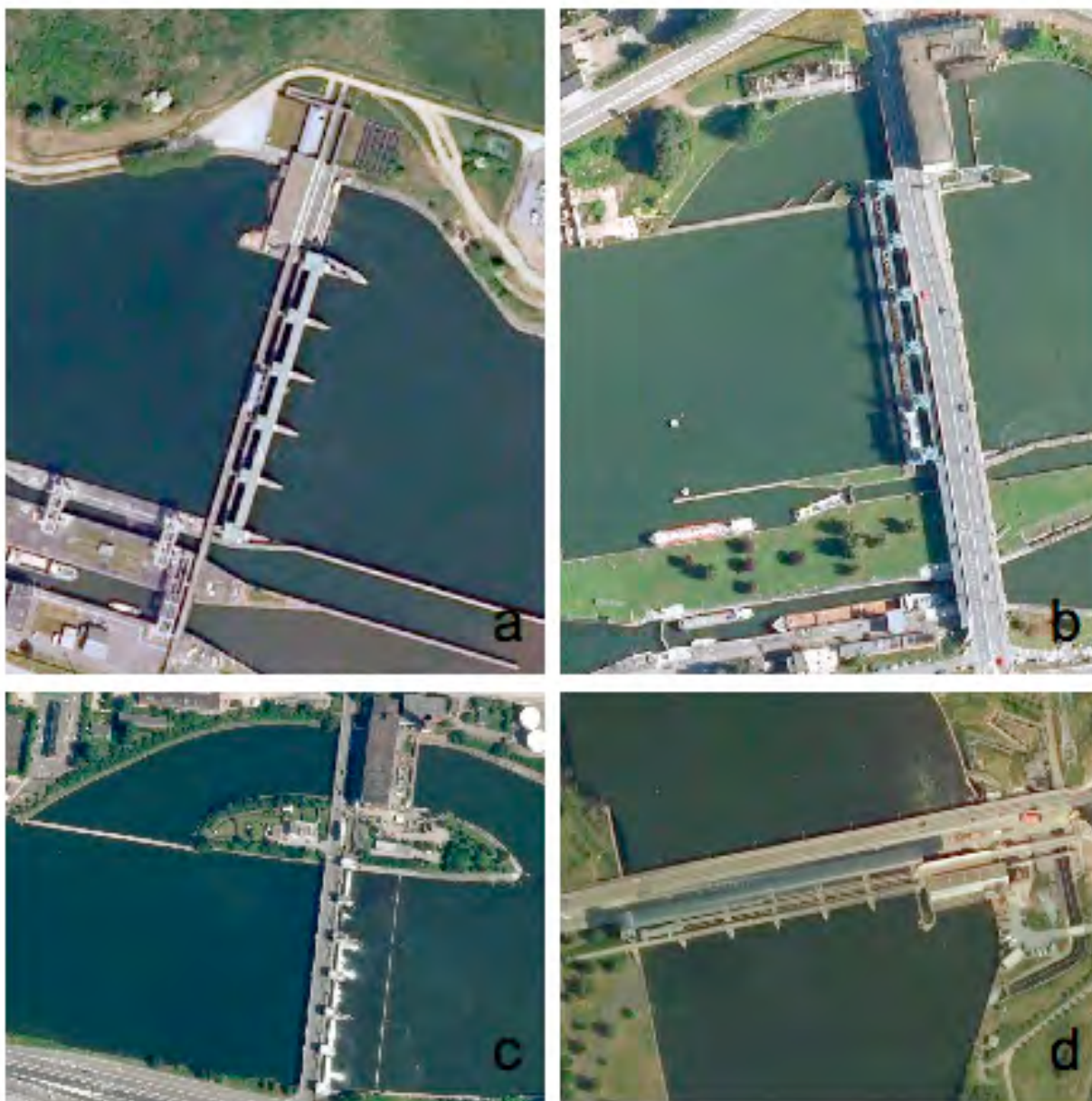
Figure 74. Vues aériennes (Google map) des sites des barrages+centrales hydroélectriques d'Ampsin-Neuville (a), Yvoz-Ramet (b), Monsin-Liège (c) et Lixhe –Visé (d) sur la Meuse liégeoise.
