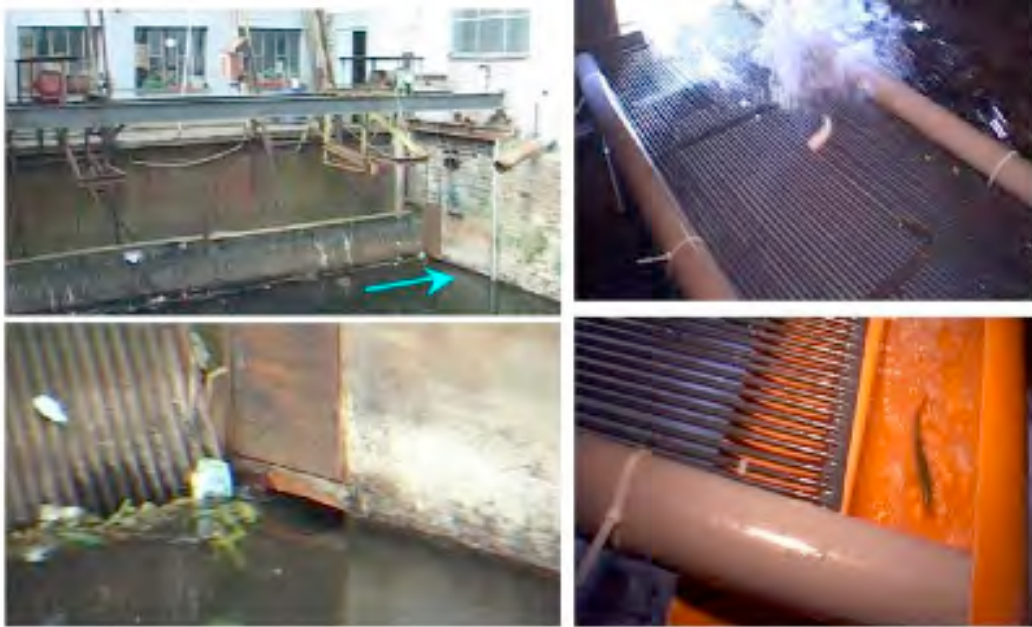
Figure 88 a. Vues (à gauche) de l'exutoire de dévalaison latéral (débit : 0,1-0,2 m 3 /s ; vitesse : 1-1,2 m 3 /s) aménagé dans le prolongement latéral de la grille de la prise d'eau de la centrale hydroélectrique Merytherm (10 m 3 /s maximum) sur l'Ourthe et (à droite) du système de récupération des poissons.
