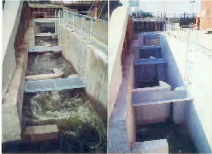
Figure 76. Partie supérieure de l'échelle à poissons à bassins du barrage de Monsin-Liège sur la Meuse (km 114,6). L'antenne de détection RFID a été placée au niveau de la dernière échancrure de la passe à poissons de Monsin.
