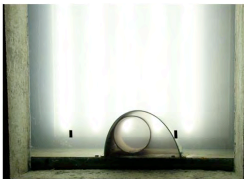
Figure 1 : Installation d'un dôme dans la passe de Waulsort.
