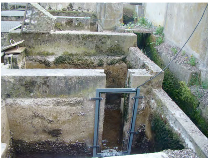
Figure 79. Au-dessus : antenne de détection CIPAM placée au niveau d'une échancrure à l'amont de la grande échelle à poissons de Lixhe sur la Meuse. En dessous : antenne de détection CIPAM placée au niveau d'une échancrure à l'amont de la petite échelle à poissons de Lixhe sur la Meuse.
