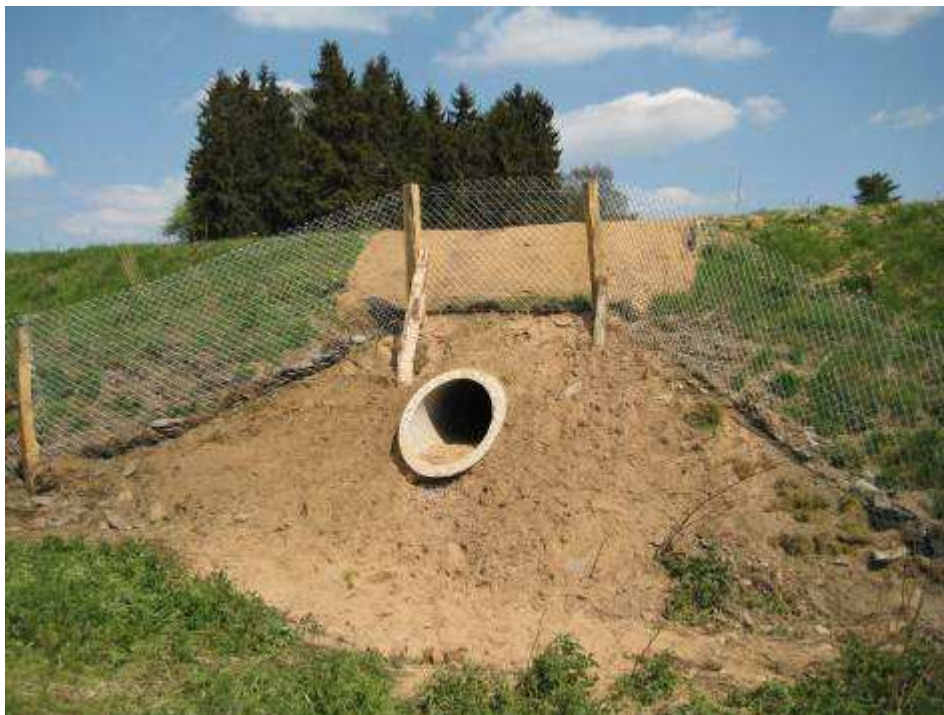
Fig. 29 : Exemple de buse sèche pour le passage de la petite faune ; Buse installée à Neimillen au Luxembourg dans le cadre du projet LIFE loutre.
