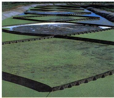
Fig.1: Lagunage par lentilles d'eau (extrait de Airone, septembre 1991)
