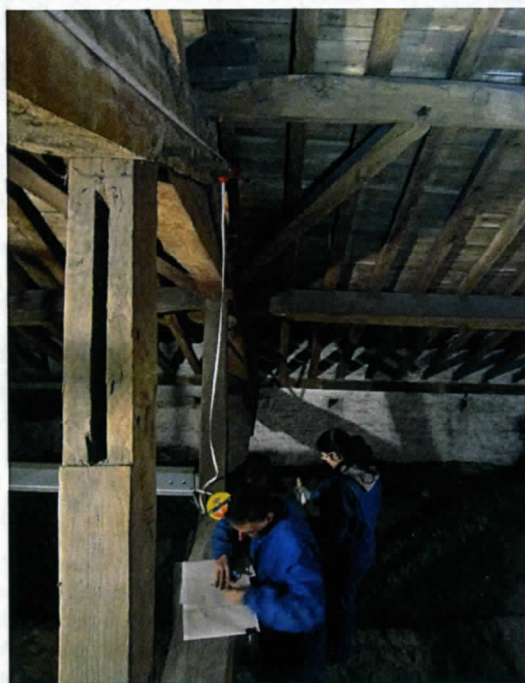
Fig.2 : Réalisation d'un relevé en coupe transversale d'une ferme de la charpente de l'église Saint-Nicolas, Neder-Over-Heembeek © Modrie S., DMS.
