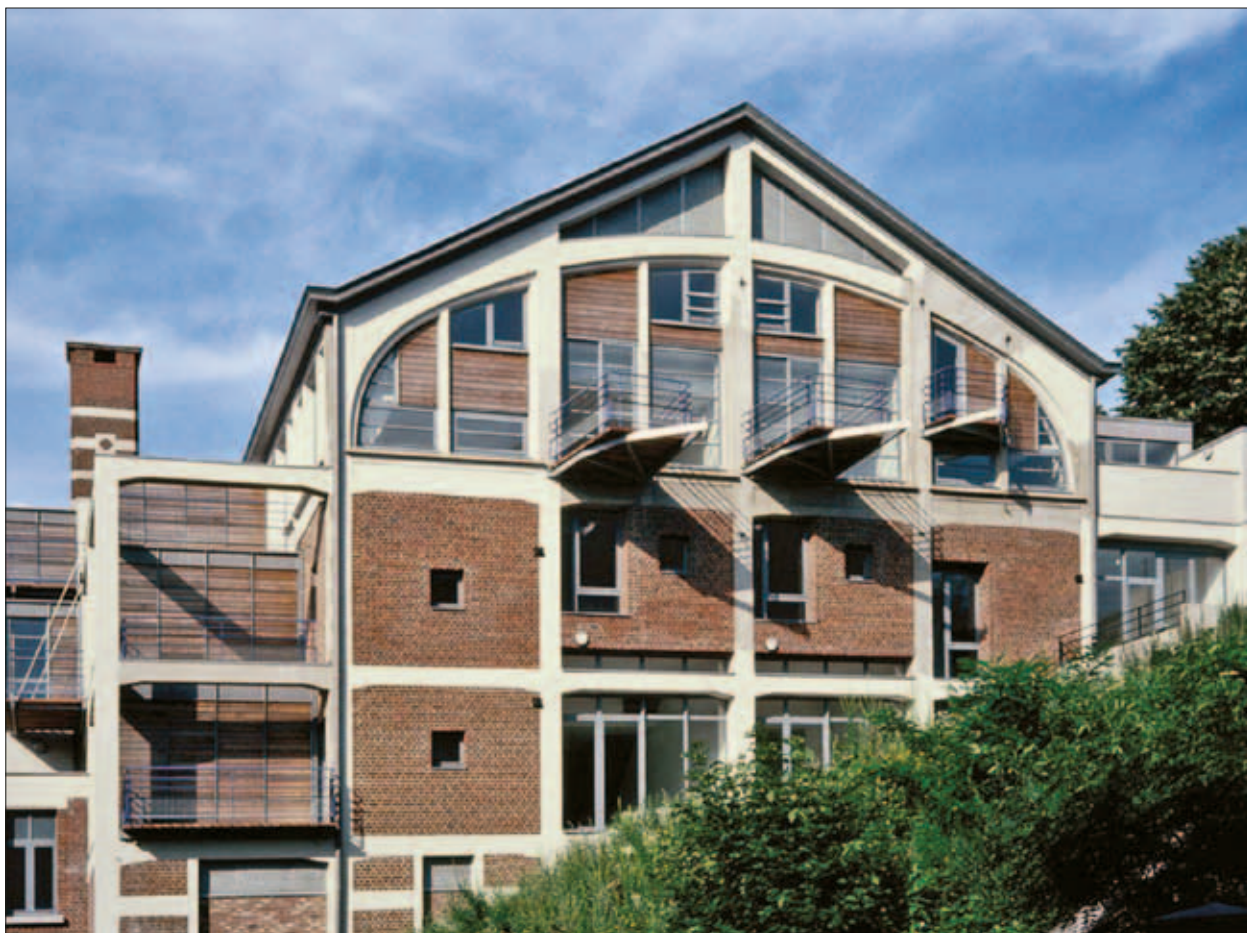
Ancienne piscine « Art Déco » de Brouchetterre (1932) reconvertie en 33 logements par les architectes Blondel et Van den Berghe – Charleroi – Photo © Pierre Blondel Architectes
