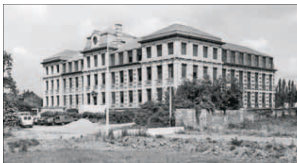
Rénovation de l'usine « Sambre et Moselle » à Montignies-sur-Sambre – arch Romain, 1993 – Photo © J.-P. Brohez
