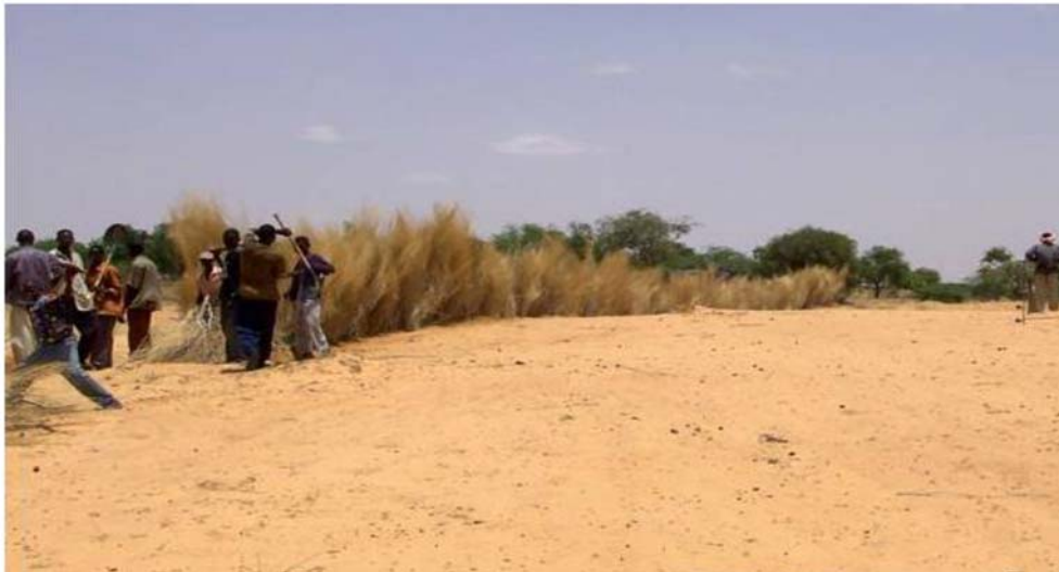
Photo1: La surface de la dune de sable dénudée de végétation au moment de la pose de la barrière mécanique anti-érosive.
