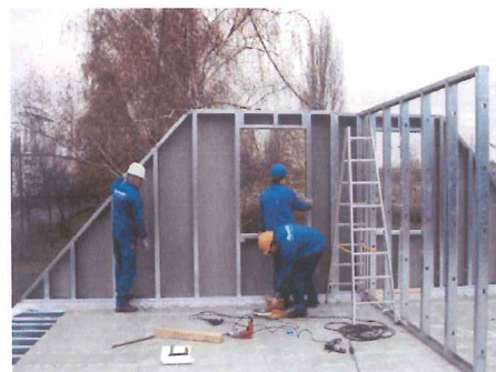
Figure 5 - Éléments de parois pour maisons uni-familiales assemblés par clinchage
