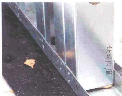
Figure 5 - Éléments de parois pour maisons uni-familiales assemblés par clinchage
