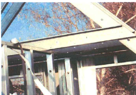
Figure 4 - Éléments de charpente et de parois minces assemblés par clinchage
