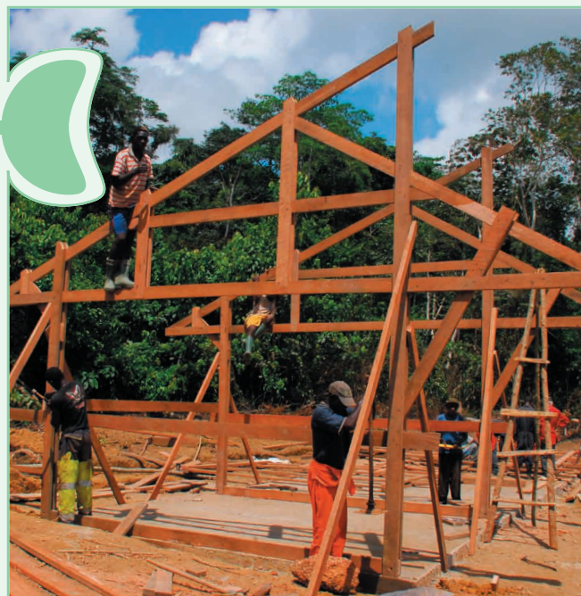
Construction d'un dispensaire villageois dans la province de l'Ogooué-Ivindo
