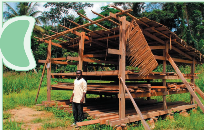
Construction d'un hangar de séchage de bois communautaire dans la province de l'Ogooué-Ivindo
