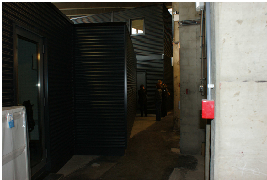
Fig.3 : Vue de l'arrière des containers disposés dans salle (ce couloir était inaccessible aux patients).
