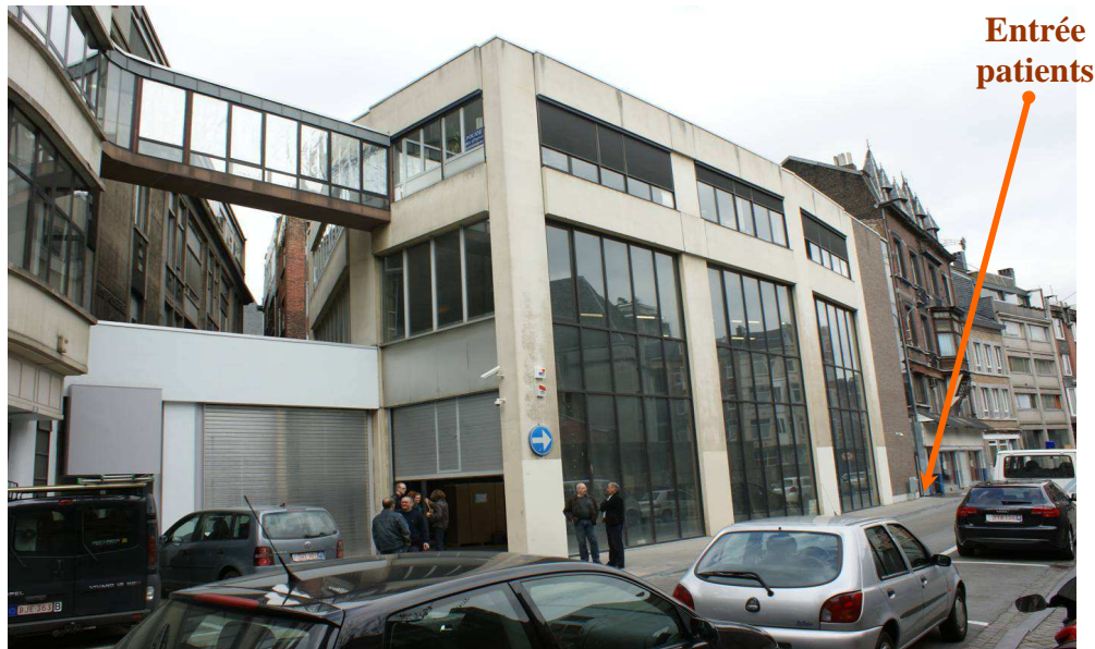
Fig. 2 : Locaux du centre DAM (à droite) conjoint au commissariat
