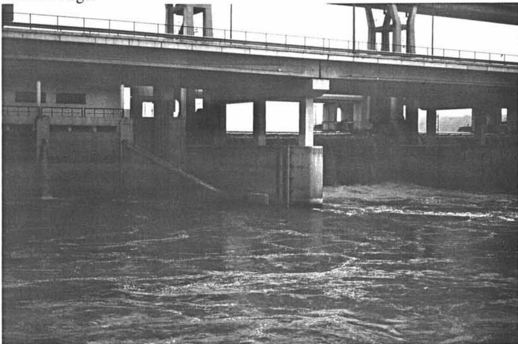
Photo 4. Vue de l'entrée de la passe migratoire en aval du barrage de Visé-Lixhe sur la Meuse belge.
