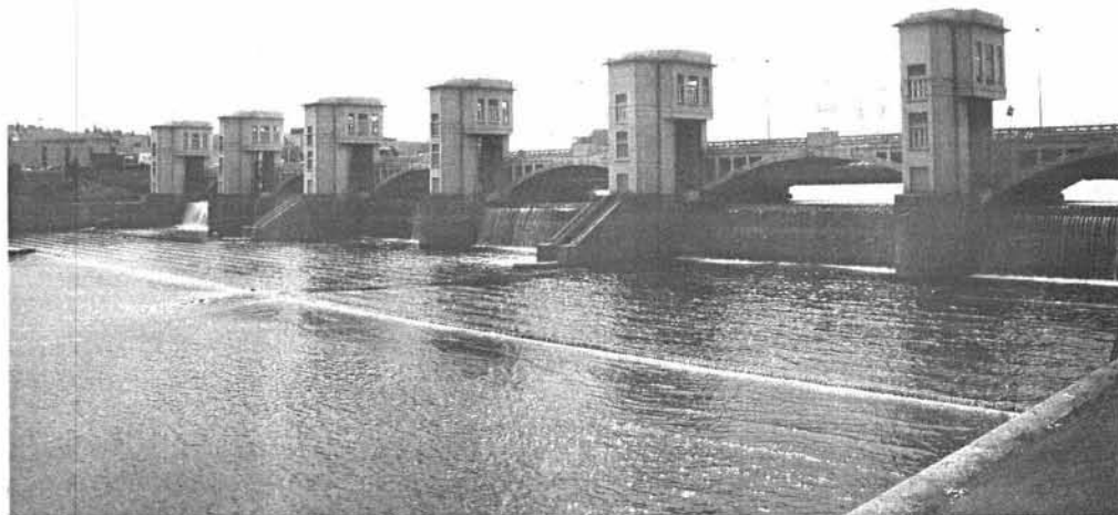
Photo 1. Barrage de Monsin le 16 juin 1997 (débit : 110 m 3 /s). Vue, à partir du môle en rive gauche, du déversoir du barrage et du radier de la Zone 1 délimitée vers l'aval par une petite chute et prolongé par une dalle de 8 m de largeur. Noter la chute d'eau réaératrice au déversoir D6, l'entrée de l'échelle à poissons Denil fonctionnelle dans la culée en rive droite et les 2 échelles Denil non fonctionnelles dans les piles entre D2/D3 et D4/D5.
