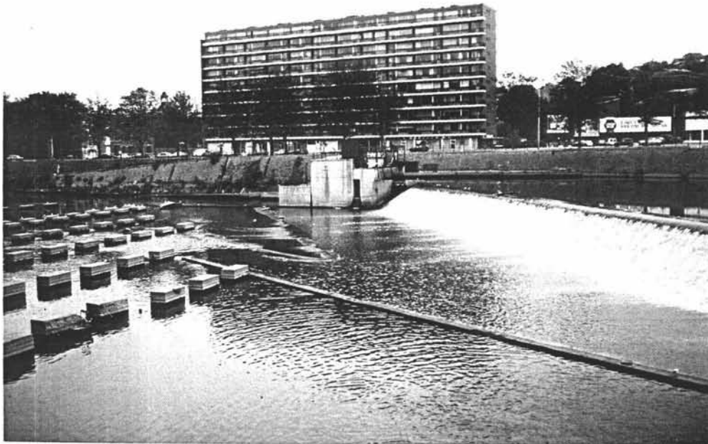
Photo 3/1. Vue du barrage des Grosses Battes à Angleur-Liège qui bloque la remontée des grands poissons migrateurs vers l'important domaine salmonicole de l'Ourthe-Ambève et affluents.
