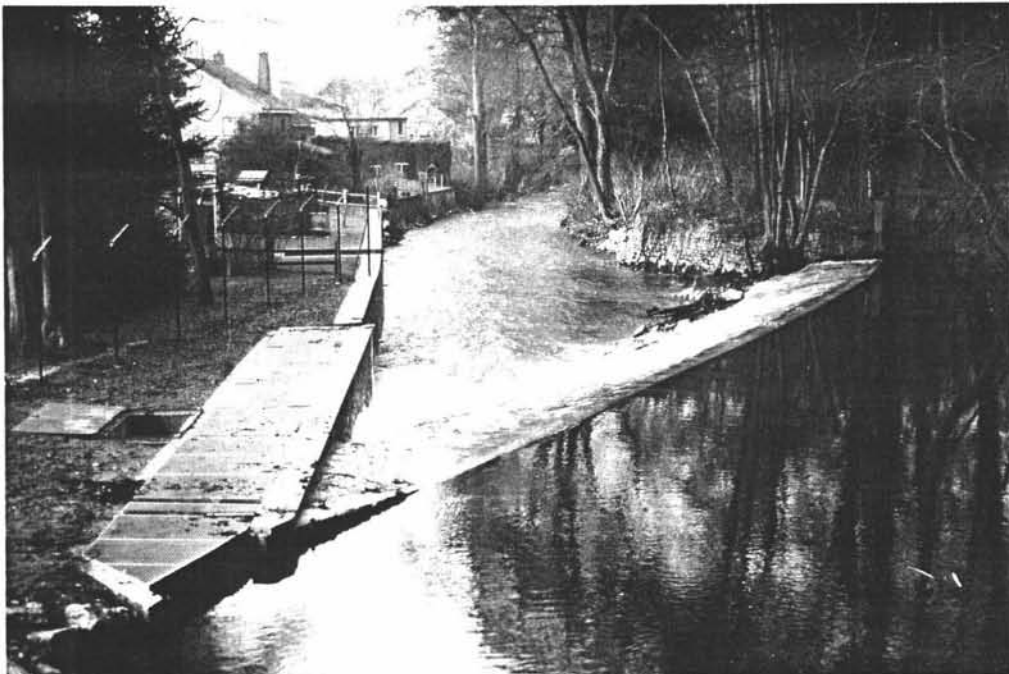
Photo 1/2. Vue du barrage de Bomal sur l'Aisne et de son échelle à poissons à bassins.
