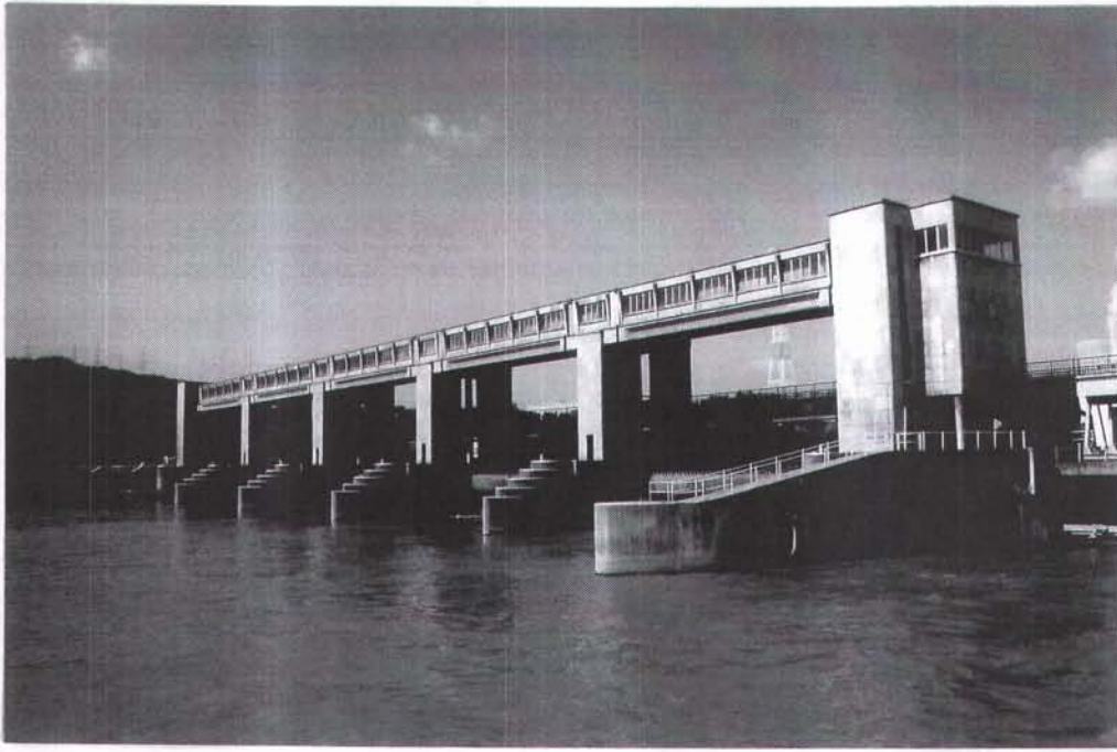
Photo 14. Vue de l'aval du barrage d'Ampsin-Neuville sur la Meuse quand les déversoirs ne fonctionnent pas. Le canal de fuite de la centrale hydro-électrique est à l'avant-plan.
