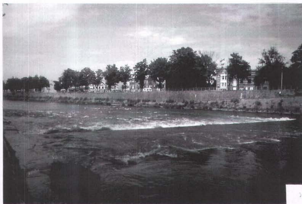
Figure 13. Zone à courant rapide, fort attrayante pour les poissons rhéophiles, en aval du barrage des Grosses Battes sur l'Ourthe.
