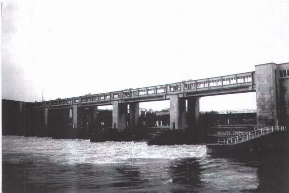
Photo 15. Vue de l'aval du barrage d'Ampsin-Neuville sur la Meuse quand les déversoirs fonctionnent . Le canal de fuite de la centrale hydro-électrique est à l'avant-plan.
