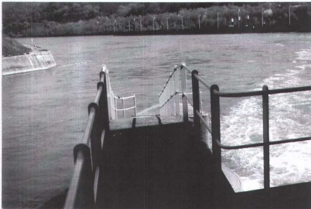
Photo. 17. Vue vers l'aval à partir du barrage d'Ampsin-Neuville sur la Meuse. A gauche du môle en béton se trouve le canal de fuite de la centrale hydro-électrique et à droite se trouvent les déversoirs et l'entrée de l'échelle à poissons Denil qui, initialement (= avant la construction de la centrale), s'ouvrait en berge gauche. Dans la situation actuelle, l'échelle Denil de rive gauche n'est attractive pour les poissons rhéophiles que lorsque les déversoirs fonctionnent.
