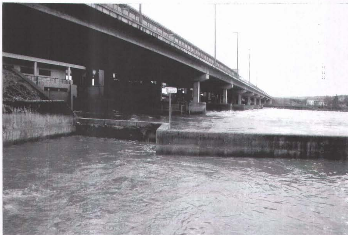
Figure 1. Vue du pied de la nouvelle échelle à poissons de Lixhe pendant la crue de fin mars 2001.
