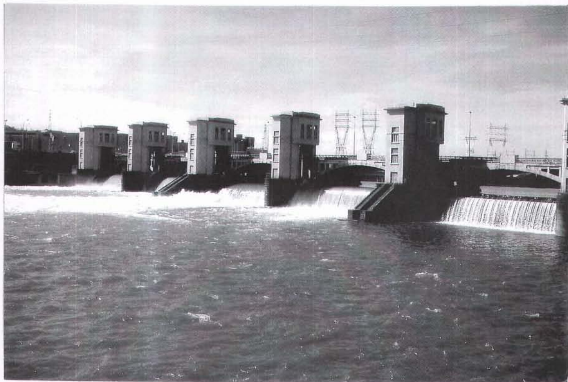
Figure 15. La Meuse en aval du barrage de Monsin en période de haut débit. L'écoulement de l'eau sur le radier peu profond en aval des déversoirs génère un habitat d'eau courante très attractif pour les poissons rhéophiles.
