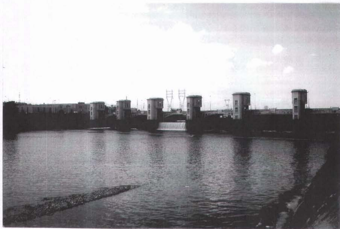
Figure 16. La Meuse en aval du barrage de Monsin en période de bas débit. On remarque un faible débit réservé (qui ne passe pas par les turbines de la centrale hydro-électrique) et un banc de gravier susceptible de servir de frayère pour les poissons rhéophiles.
