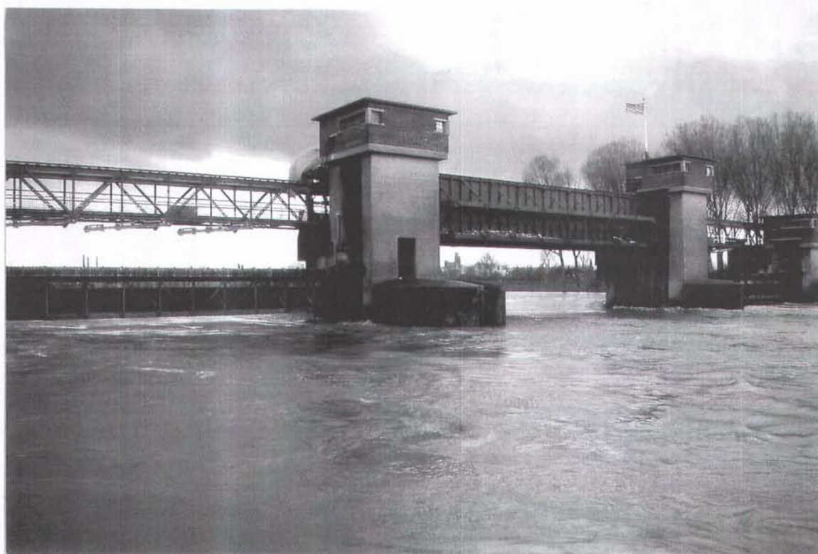
Figure 2. Vue du barrage de Borgharen-Maastricht largement ouvert pendant la crue de fin mars 2001 (le 23 mars : 1332 m 3 /s à Lixhe).
