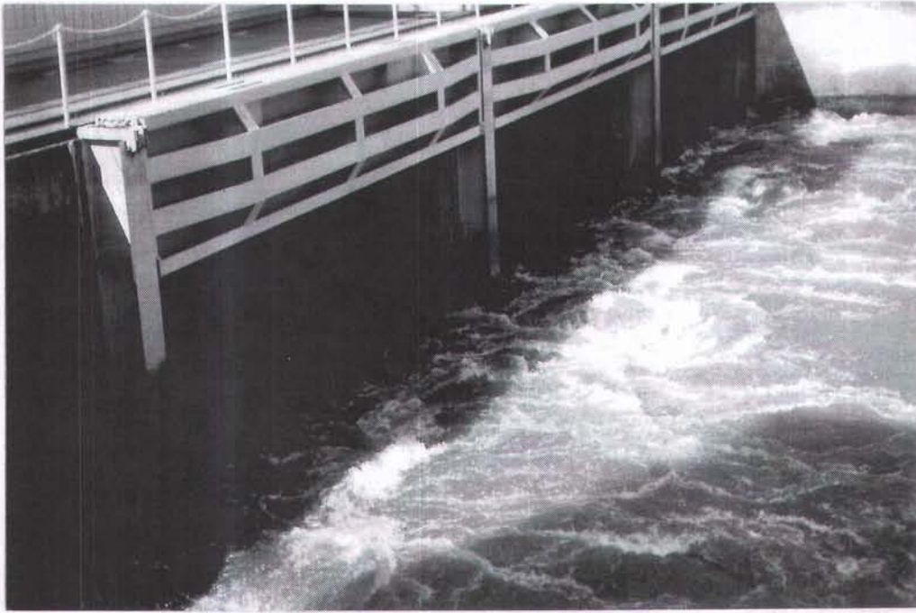
Photo. 16. Sortie des turbines de la centrale hydro-électrique du barrage d'Ampsin-Neuville sur la Meuse. Débit d'équipement : 270 m 3 /s.
