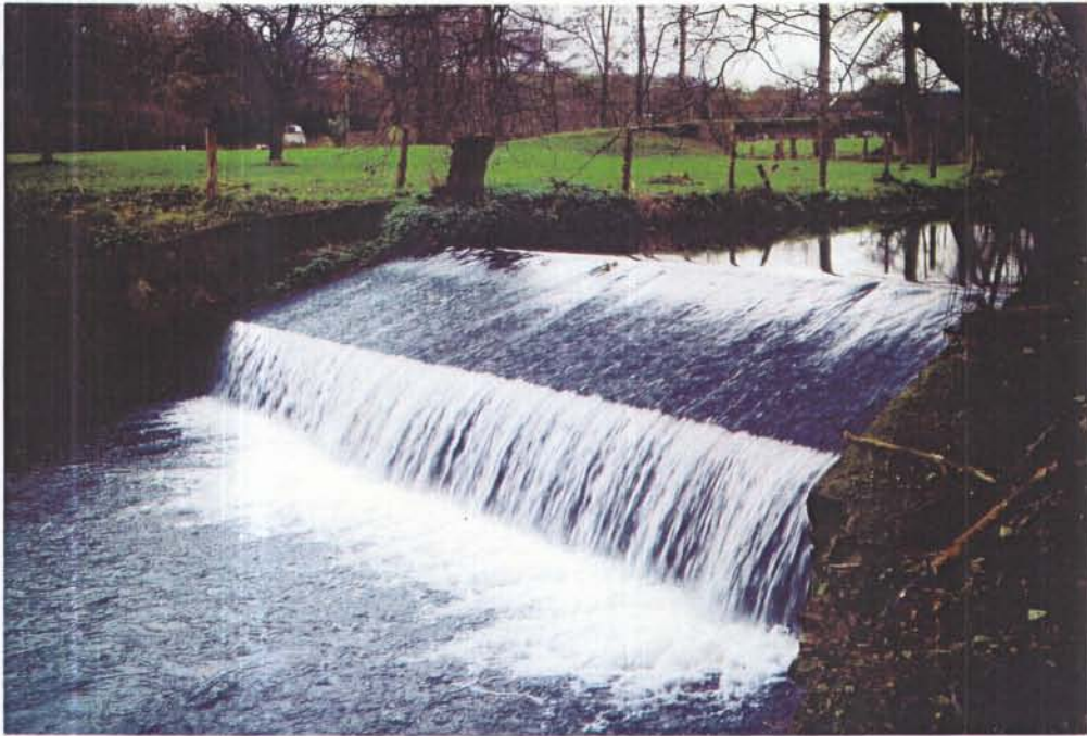
Photos 2/2. Vue du site du barrage de Mortroux (30 m en amont de la confluence du Ruisseau d'Asse) dans sa configuration avant (au-dessus) et après (en-dessous) l'aménagement par la DCENN en 2004 d'une passe migratoire avec piège de capture.
