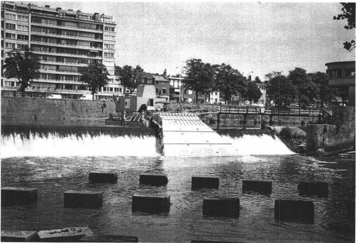
Photos 2/ 5. Vue du barrage des Grosses Battes sur la basse Ourthe à Angleur montrant la position de la nouvelle centrale hydro-électrique flottante (A) par rapport à l'ancienne centrale en rive droite et (B) par rapport à l'échelle à poissons Denil à l'emplacement de laquelle sera construite la nouvelle échelle à bassins.
