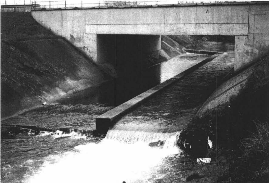
Photo 2/8. Le seuil artificiel au niveau du passage sous-routier sur la basse Berwinne à Mouland (éRgion flamande) dans deux configurations de débit.
