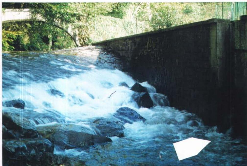
Photo 2/4. Vue du barrage de Bomal sur l'Aisne montrant (flèche) l'entrée de l'échelle à poissons.
