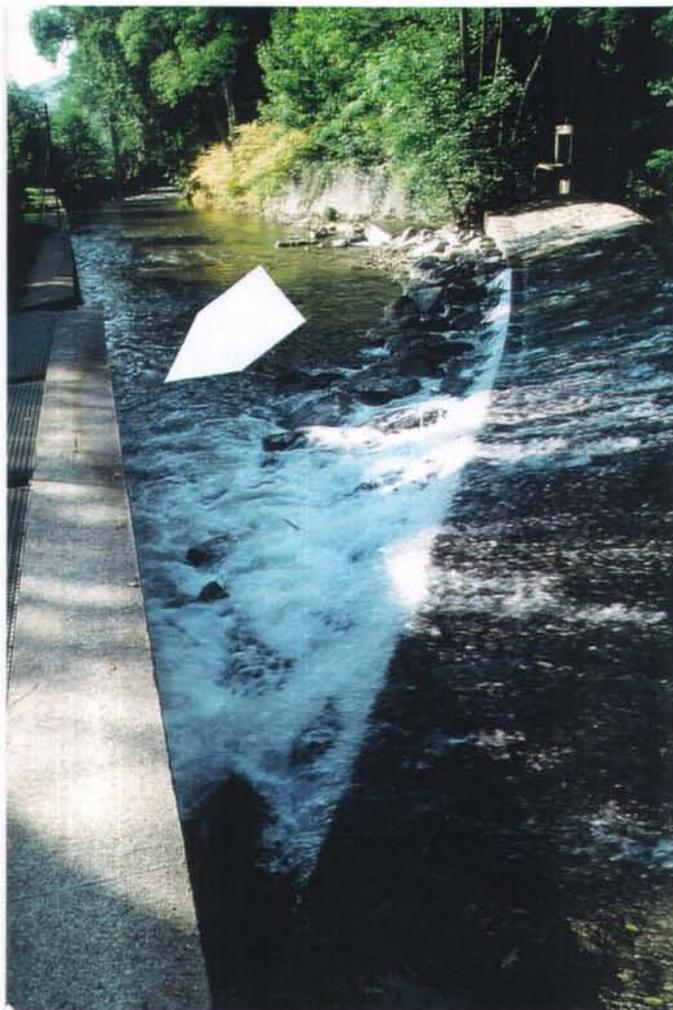
Photo 2/3. Vue du barrage de Bomal sur la basse Aisne en période de faible débit. L'échelle à poissons située en rive gauche (couverture de caillebotis) s'ouvre dans la rivière au point indiqué par la flèche.
