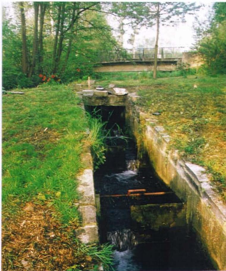
Photo 2/2. La passe à poissons à bassins du barrage de Moha en basse Méhaigne montrant spécialement la zone de piégeage.
