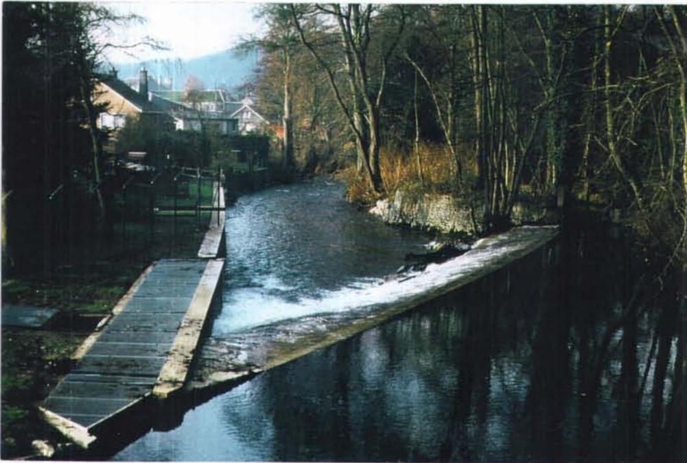
Photo 4/1. L'échelle à poissons du barrage de Bomal sur l'Aisne en condition d'étiage
