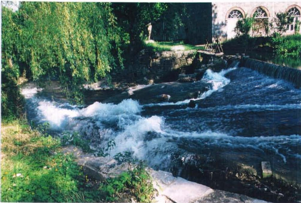
Photo 2/1. Le barrage avec microcentrale hydro-électrique de Moha en basse Méhaigne dans sa nouvelle configuration avec rehaussement et bétonnage en fin 1997.
