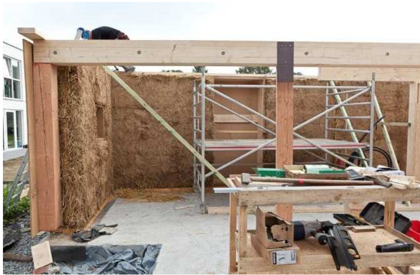
(Photo Lefrancq, Chantier Paille-Tech à Mons 2011, http://www.pailletech.be )
