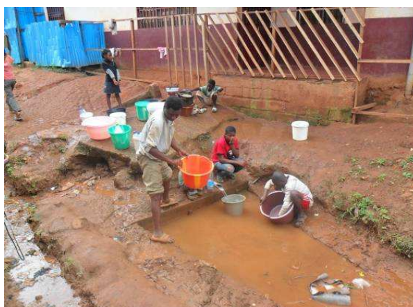
Fig. 100 : Source aménagée mal entretenue à Oyomabang
