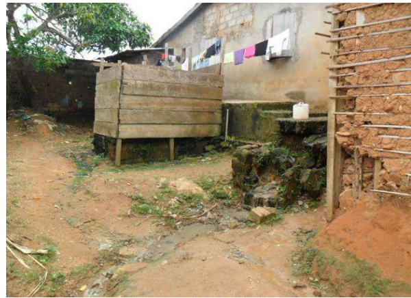
Fig. 105 : Latrine à fond perdu jouxtant un puits à Nkolbikok
