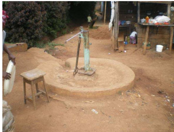
Fig. 102 : Forage hors service à Etetack
