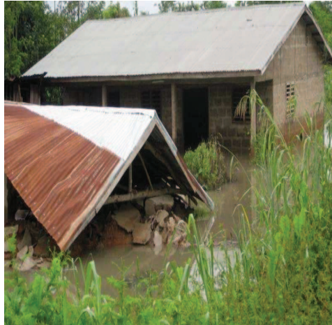
Photo 1 : Le village de Kpoto inondé le 16 septembre 2010 et vulnérabilité contrastée en fonction du type de matériau de construction (Ahouangan, 2012)
