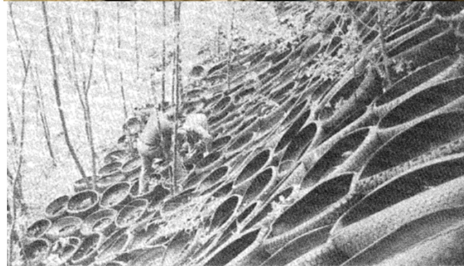
protection des pentes en Suisse
