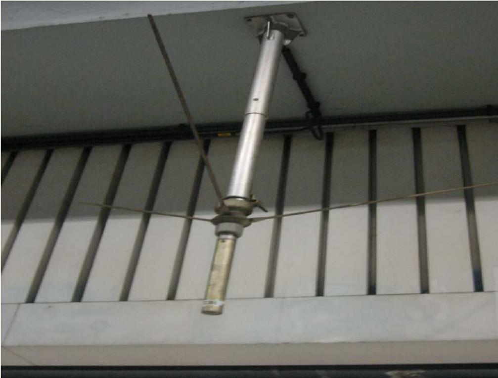
FIGURE 10.3 – Antenne GSM (station de métro Rogier, Bruxelles).
