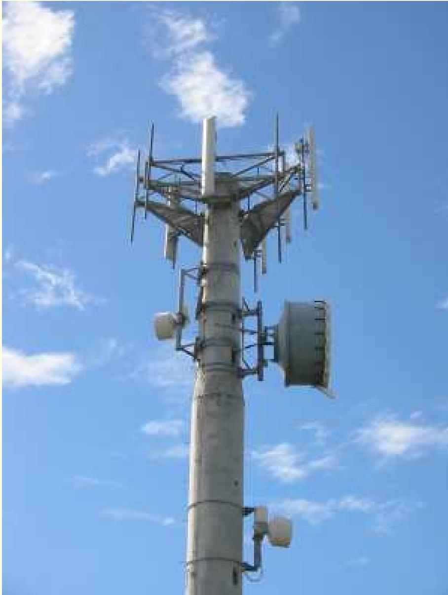
FIGURE 9.10 – Exemple d’antennes GSM et paraboliques (ROCKHAMPTON, QUEENSLAND, AUSTRALIE).
