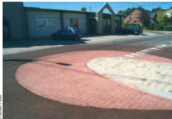
Carrefour aménagé avec un îlot en pierre naturelle et béton imprimé avec un rendu de type "Brick" (brique).
