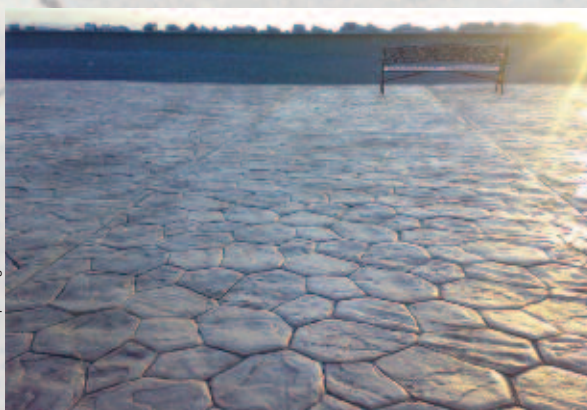
Surface en béton imprimé par moule imitant un dallage de pierre naturelle en opus incertum.
