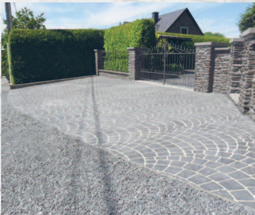
Entrée de propriété en béton imprimé avec une surface de type "European Fan" (éventail européen).
