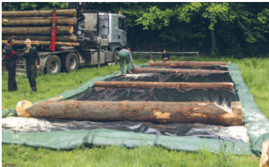
Pour la stabilité de la pile, des entailles sont pratiquées aux extrémités des traverses.
