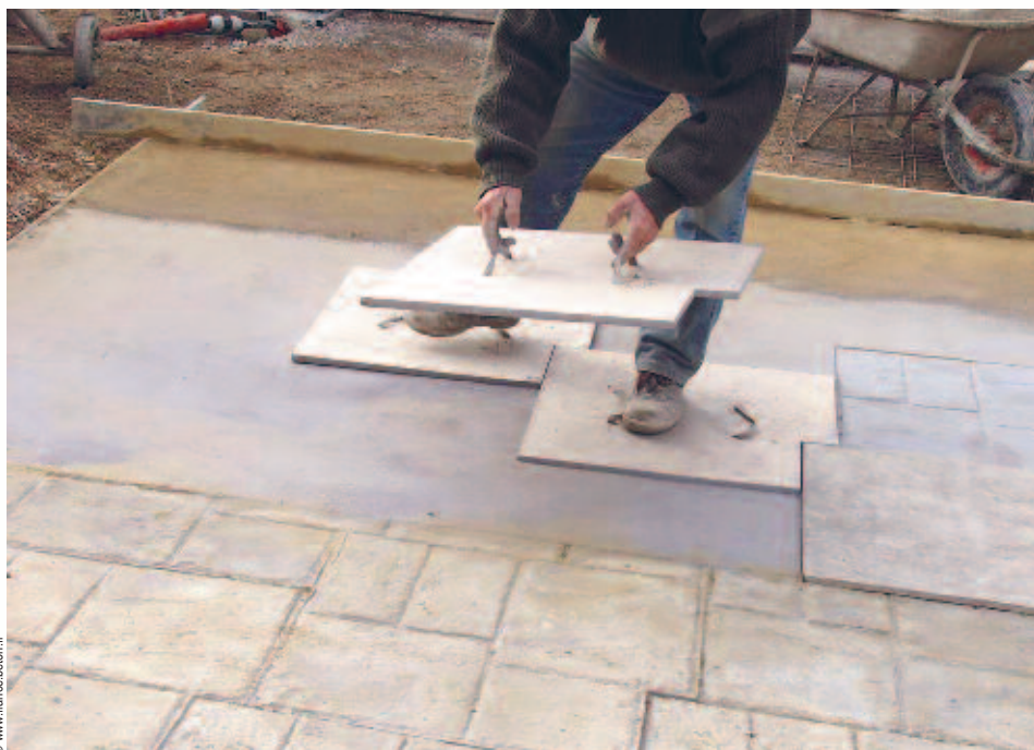
Moulage d'une surface en béton imprimé.
