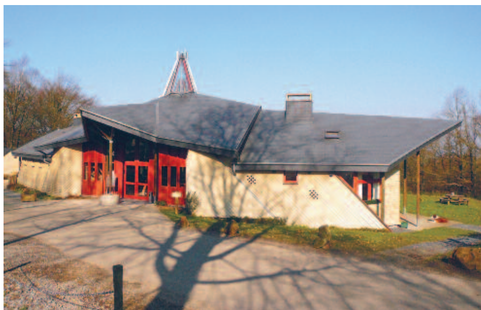
Le pavillon d'accueil du Parc Chlorophylle présente un bardage déposé en angle qui renforce la dynamique du bâtiment.
