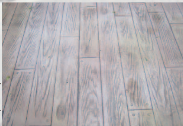
Surface en béton imprimé par moule imitant le bois.
