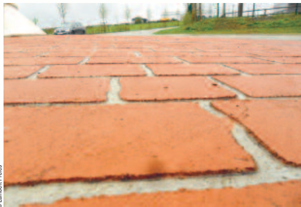
Détail d'une surface de type "Rustic brick" (brique rustique).
