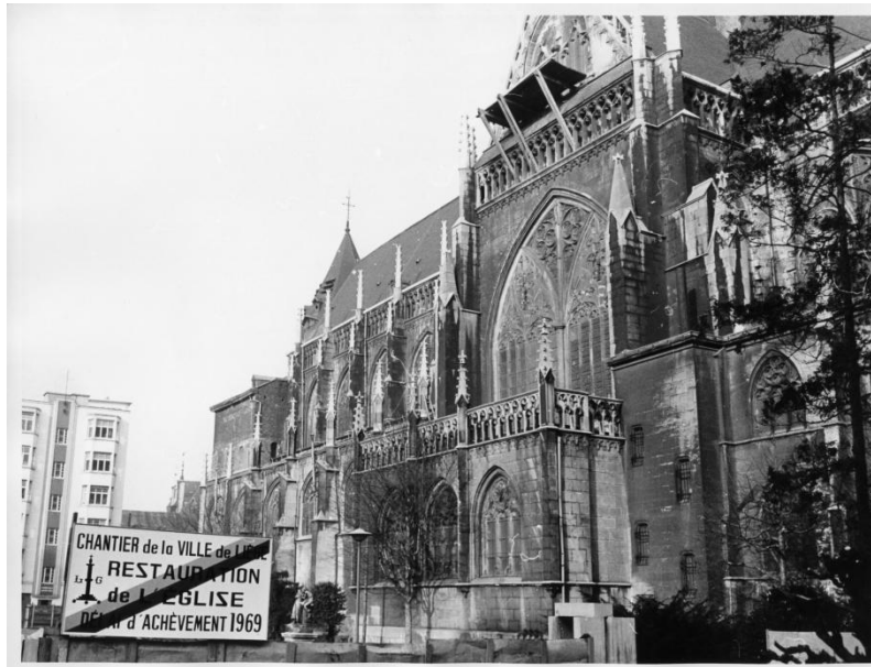
La façade sud de l'église, lors des travaux, en 1968.
