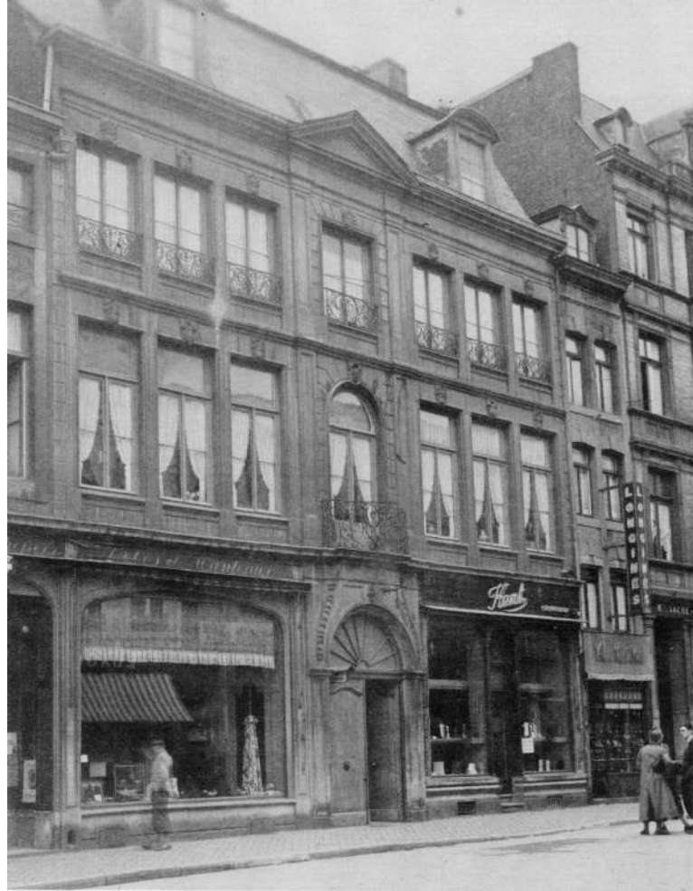
Figure 3 : maison à entrée cochère du Vinâve-d'Île en 1941. © Bruxelles, KIK-IRPA.
