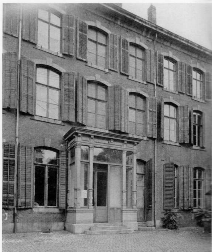
Figure 1 : hôtel décanal de Saint-Paul en 1955. © Bruxelles, KIK-IRPA.
