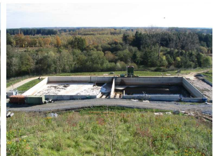
Photo 9 : Station d'épuration, partie aération-décantation
