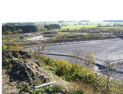
Photo 11 : Nouveau casier en préparation, partie sud
