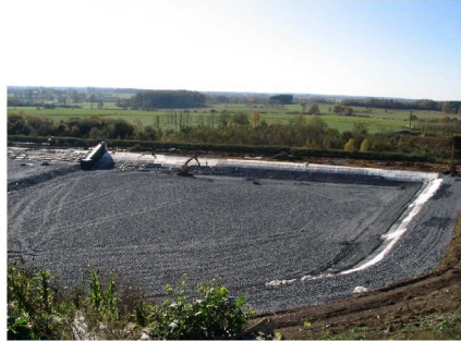
Photo 12 : Nouveau casier en préparation, partie nord
