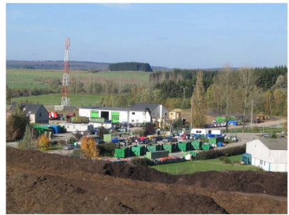
Photo 7 : Parc à containers
