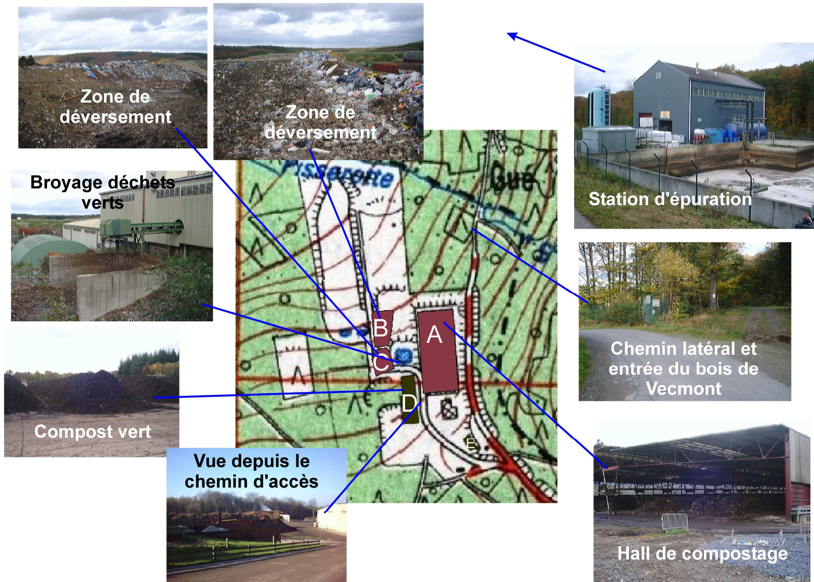
Figure 4 : Vue rapprochée du CET et du Centre de Compostage de Tenneville
