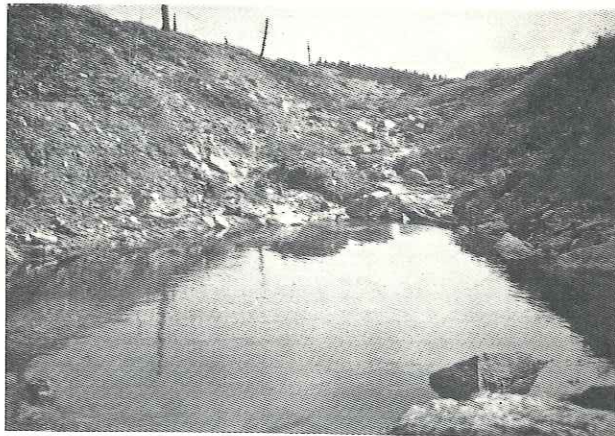
Fig. 4 — Le fossé d'Éupen, mai 1948. Ravinement.
