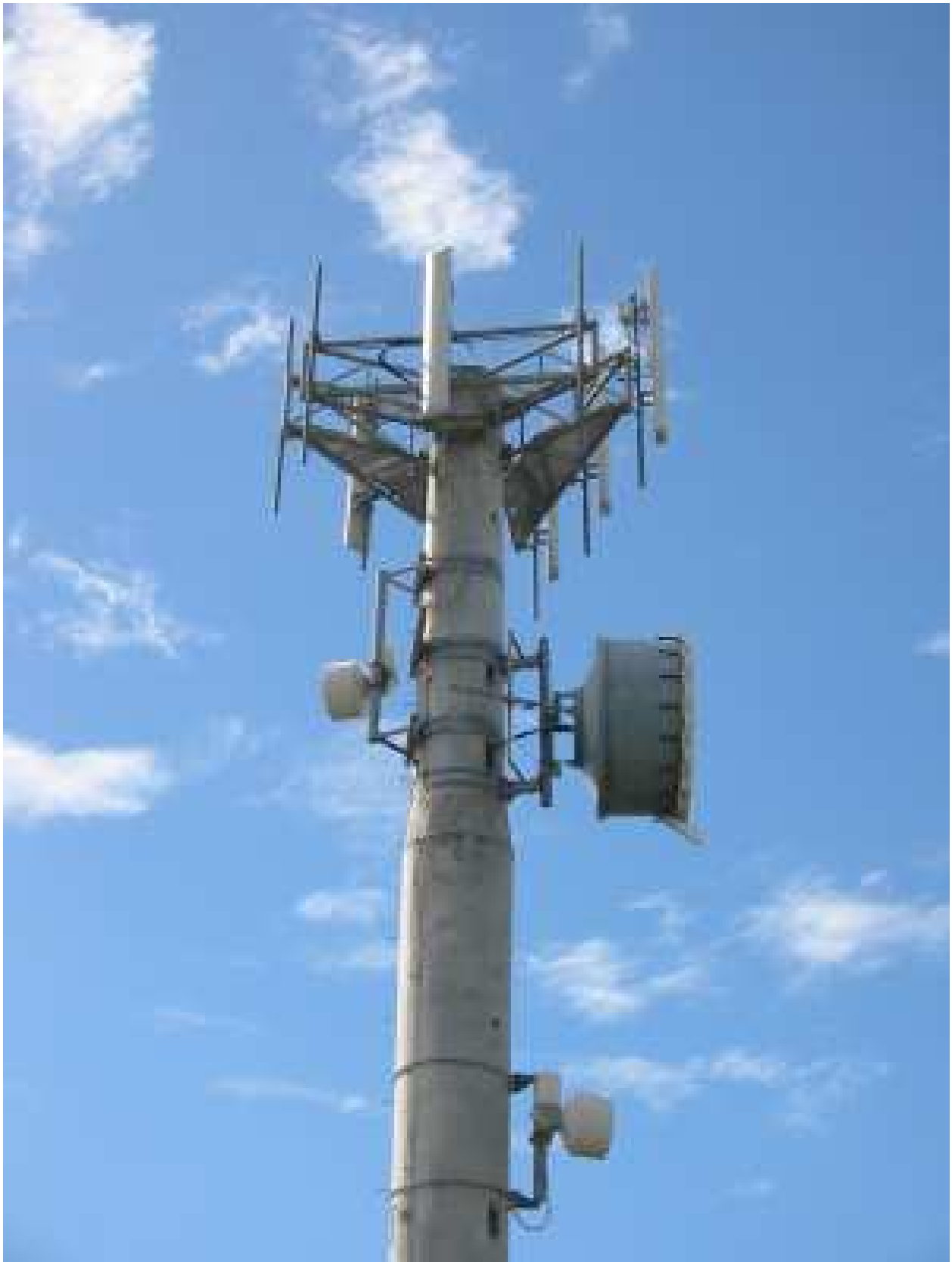
FIG. 3 – Exemple d'antennes GSM (ROCKHAMPTON, QUEENSLAND, AUSTRALIE).
