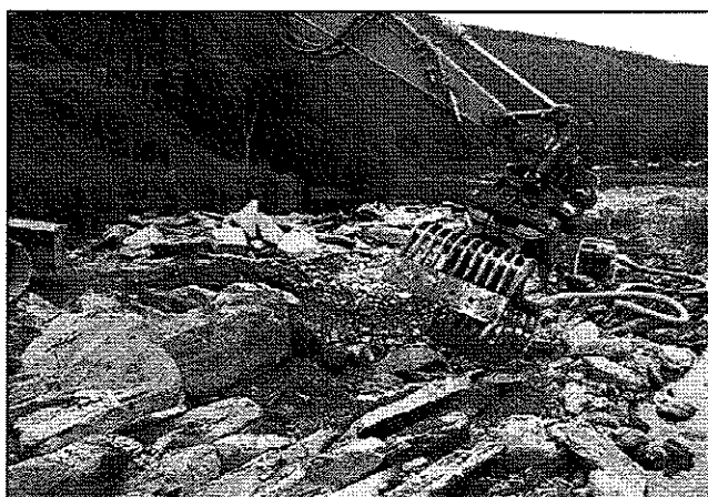
Figure 6 : Pose du perré crêté au barrage de Alle (Photo F. Rosillon, 2006)
