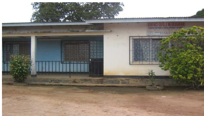
Photo 51 : Vue extérieur du siège de ADEAC à Ayos ( Lekane, 15 juin 2007)
