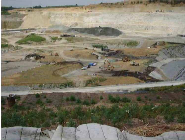
Photo 2.7 : Vue générale du CET d'Hallembaye
